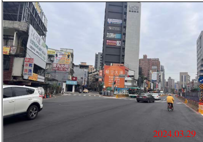
巡查日期地點：113.03.29/ Y21車站 照片說明：路面狀況
