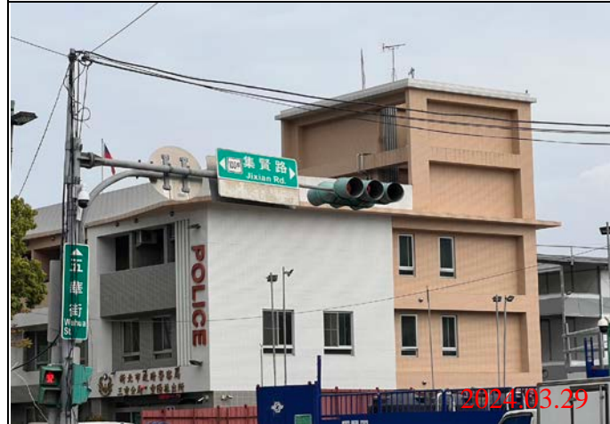
巡查日期地點：113.03.29/ Y22車站 照片說明：牌面設置狀況
