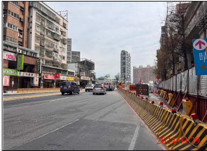
巡查日期地點：113.03.29/ Y22車站 照片說明：路面狀況
