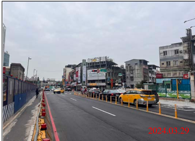
巡查日期地點：113.03.29/ Y21車站 照片說明：路面狀況
