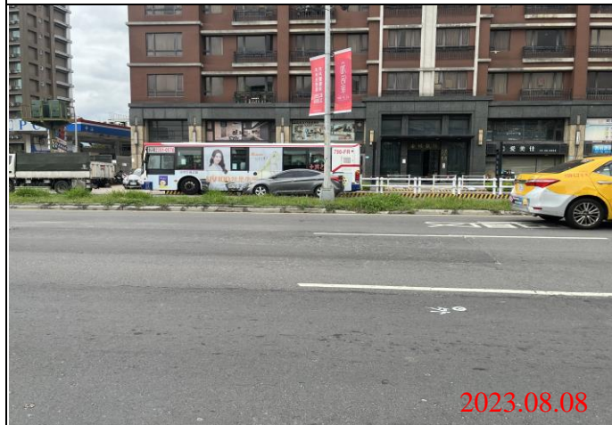
巡查日期地點：112.08.08/ Y23車站 照片說明：路面龜裂狀況
