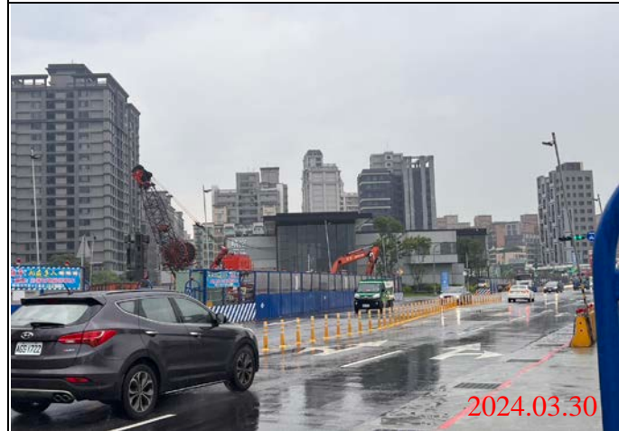
巡查日期地點：113.03.30/ Y22車站 照片說明：路面狀況
