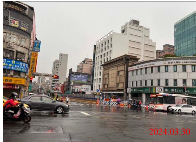
巡查日期地點：113.03.30/ Y21車站 照片說明：路面狀況
