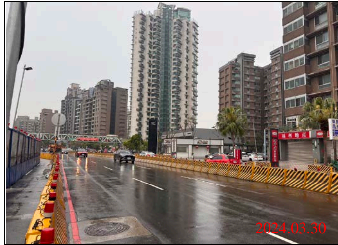
巡查日期地點：113.03.30/ Y23車站 照片說明：路面狀況
