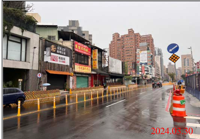
巡查日期地點：113.03.30/ Y21車站 照片說明：路面狀況
