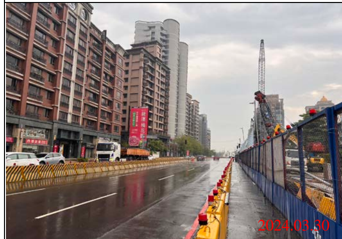
巡查日期地點：113.03.30/ Y23車站 照片說明：路面狀況
