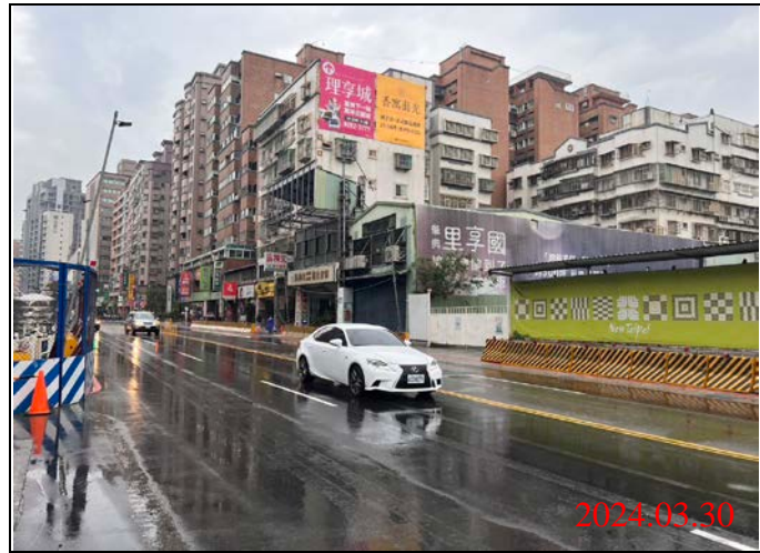
巡查日期地點：113.03.30/ Y22車站 照片說明：路面狀況
