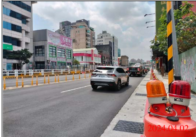
巡查日期地點：113.04.02/ Y21車站 照片說明：路面狀況
