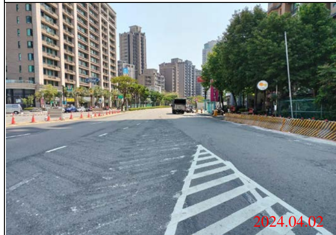
巡查日期地點：113.04.02/ Y22車站 照片說明：路面狀況
