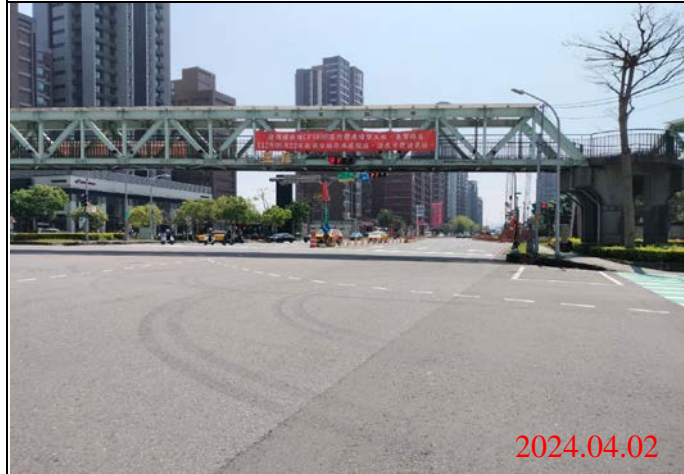
巡查日期地點：113.04.02/ Y23車站 照片說明：路面狀況
