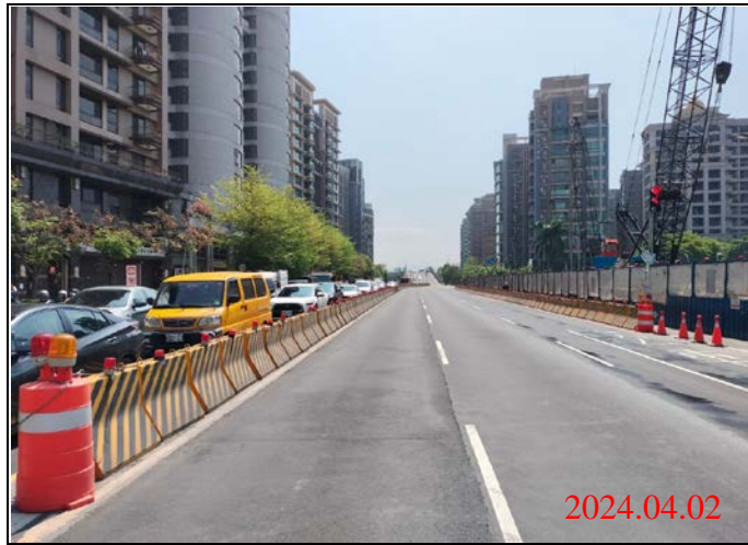
巡查日期地點：113.04.02/ Y23車站 照片說明：路面狀況
