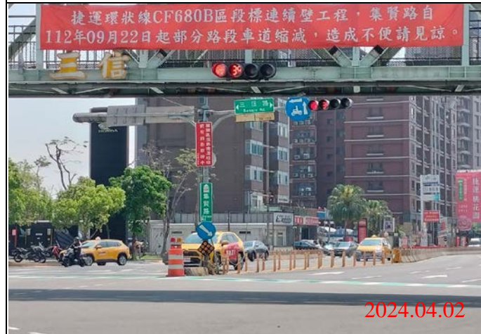
巡查日期地點：113.04.02/ Y23車站 照片說明：牌面設置狀況
