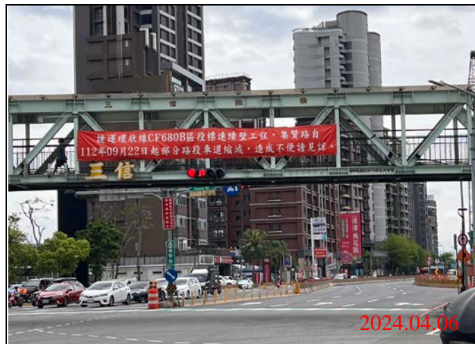
巡查日期地點：113.04.06/ Y23車站 照片說明：路面狀況
