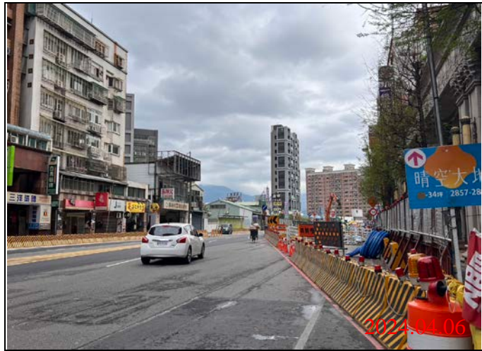
巡查日期地點：113.04.06/ Y22車站 照片說明：路面狀況
