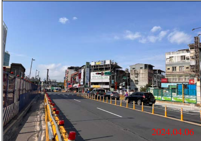
巡查日期地點：113.04.06/ Y21車站 照片說明：路面狀況
