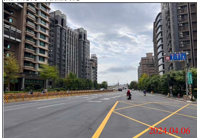
巡查日期地點：113.04.06/ Y23車站 照片說明：路面狀況
