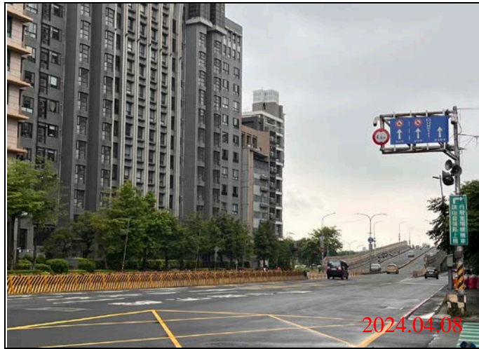
巡查日期地點：113.04.08/ Y23車站 照片說明：路面狀況
