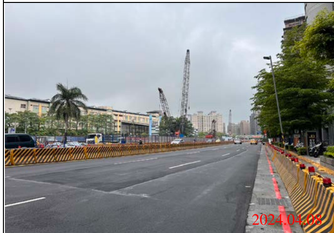
巡查日期地點：113.04.08/ Y23車站 照片說明：路面狀況
