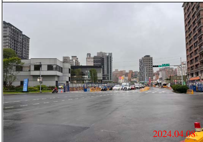
巡查日期地點：113.04.08/ Y22車站 照片說明：路面狀況
