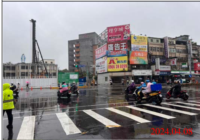
巡查日期地點：113.04.08/ Y21車站 照片說明：路面狀況
