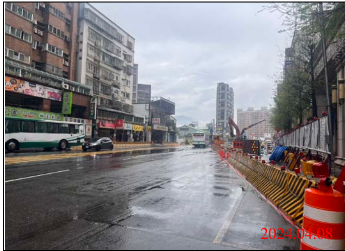
巡查日期地點：113.04.08/ Y22車站 照片說明：路面狀況
