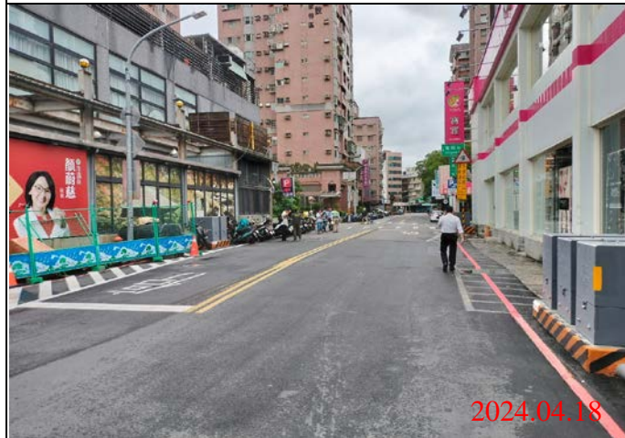
巡查日期地點：113.04.18/ Y21車站 照片說明：路面狀況
