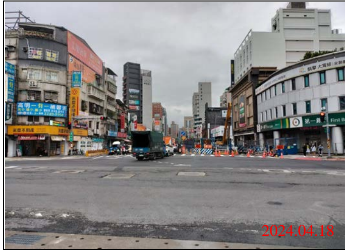
巡查日期地點：113.04.18/ Y21車站 照片說明：路面狀況
