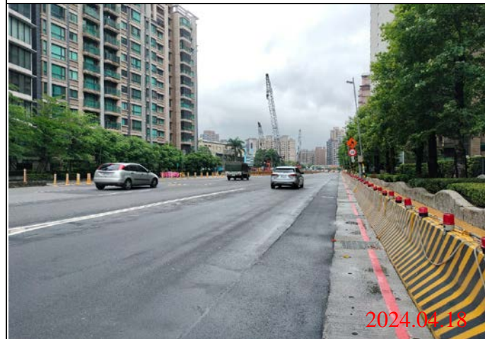
巡查日期地點：113.04.18/ Y23車站 照片說明：路面狀況
