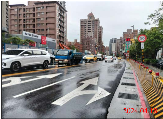
巡查日期地點：113.04.18/ Y22車站 照片說明：路面狀況
