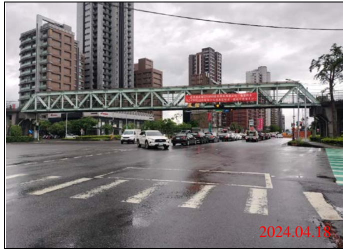
巡查日期地點：113.04.18/ Y23車站 照片說明：路面狀況
