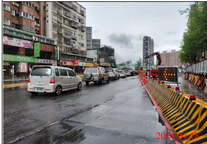
巡查日期地點：113.04.18/ Y22車站 照片說明：路面狀況
