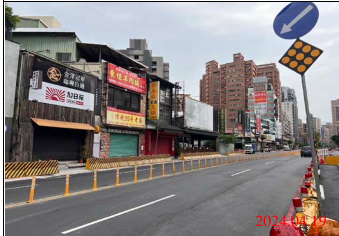
巡查日期地點：113.04.19/ Y21車站 照片說明：路面狀況
