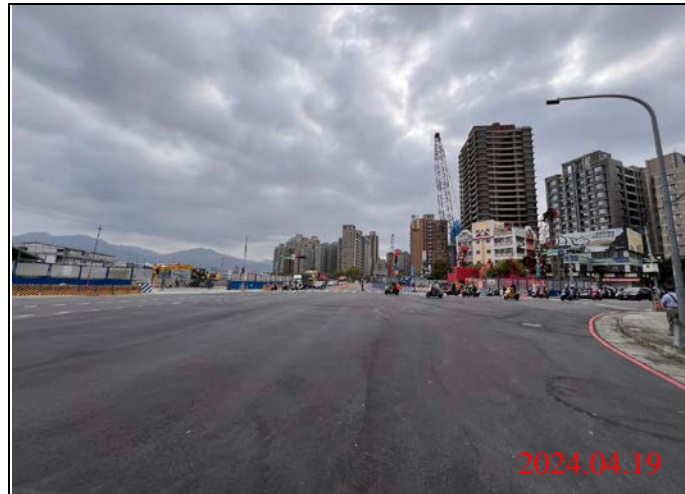
巡查日期地點：113.04.19/ Y22車站 照片說明：路面狀況
