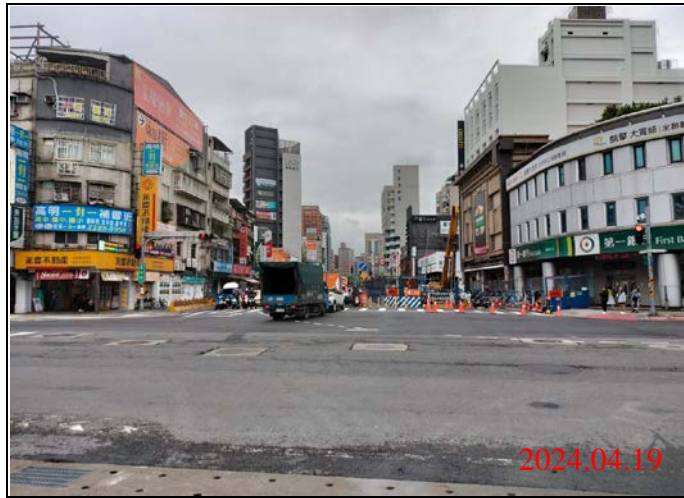
巡查日期地點：113.04.19/ Y21車站 照片說明：路面狀況
