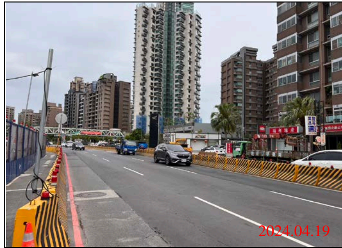
巡查日期地點：113.04.19/ Y23車站 照片說明：路面狀況
