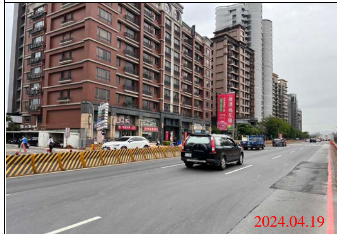
巡查日期地點：113.04.19/ Y23車站 照片說明：路面狀況
