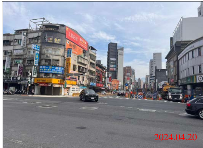
巡查日期地點：113.04.20/ Y21車站 照片說明：路面狀況
