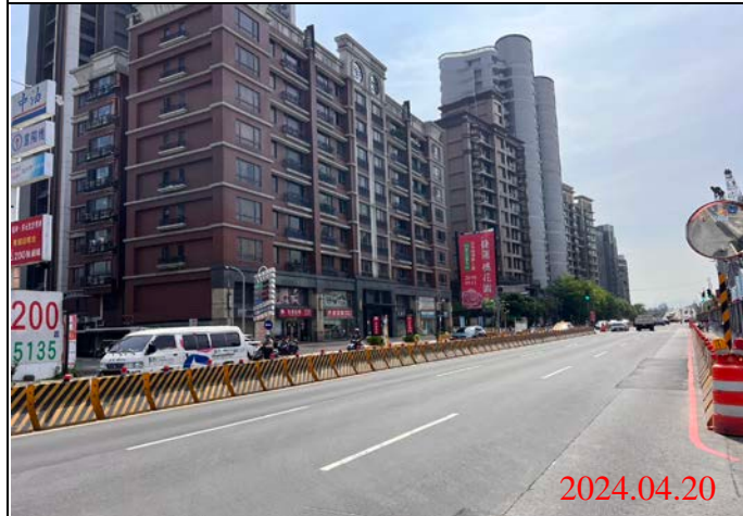
巡查日期地點：113.04.20/ Y23車站 照片說明：路面狀況
