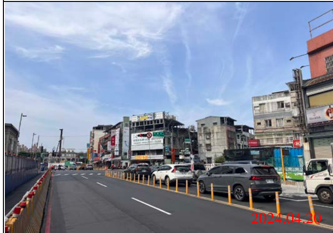
巡查日期地點：113.04.20/ Y21車站 照片說明：路面狀況
