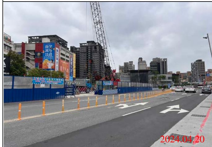
巡查日期地點：113.04.20/ Y22車站 照片說明：路面狀況
