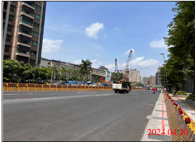
巡查日期地點：113.04.20/ Y23車站 照片說明：路面狀況
