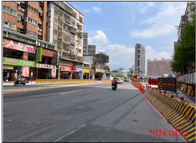
巡查日期地點：113.04.21/ Y22車站 照片說明：路面狀況
