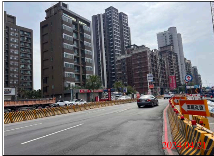
巡查日期地點：113.04.21/ Y23車站 照片說明：路面狀況
