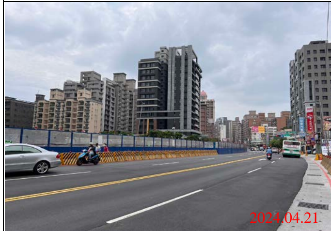
巡查日期地點：113.04.21/ Y22車站 照片說明：路面狀況
