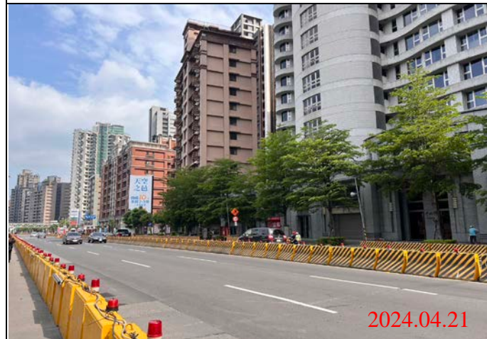
巡查日期地點：113.04.21/ Y23車站 照片說明：路面狀況
