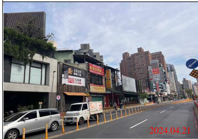
巡查日期地點：113.04.21/ Y21車站 照片說明：路面狀況
