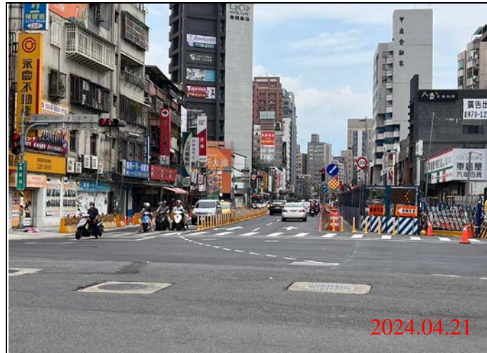
巡查日期地點：113.04.21/ Y21車站 照片說明：路面狀況
