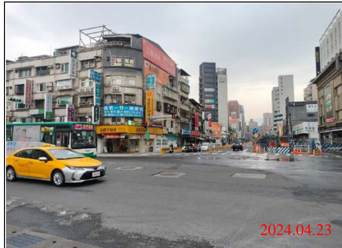
巡查日期地點：113.04.23/ Y21車站 照片說明：路面狀況
