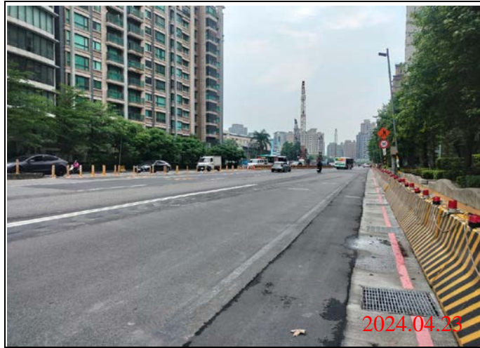
巡查日期地點：113.04.23/ Y23車站 照片說明：路面狀況
