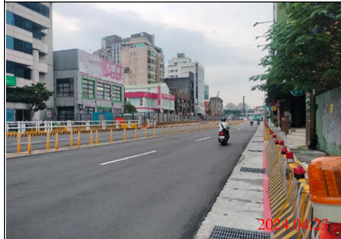
巡查日期地點：113.04.23/ Y21車站 照片說明：路面狀況
