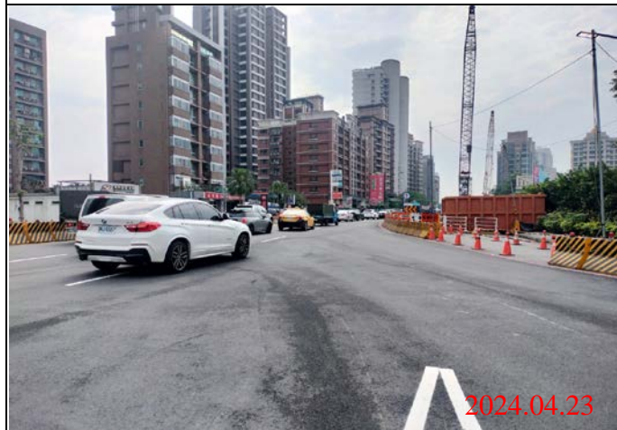
巡查日期地點：113.04.23/ Y23車站 照片說明：路面狀況
