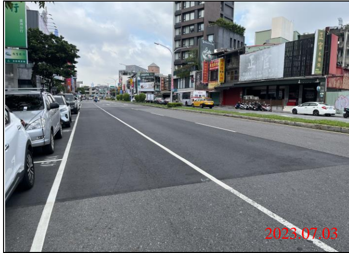
巡查日期地點：112.07.03/ Y21車站 照片說明：路面狀況
