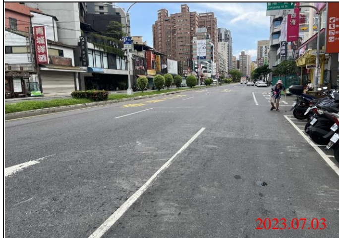
巡查日期地點：112.07.03/ Y21車站 照片說明：路面狀況
