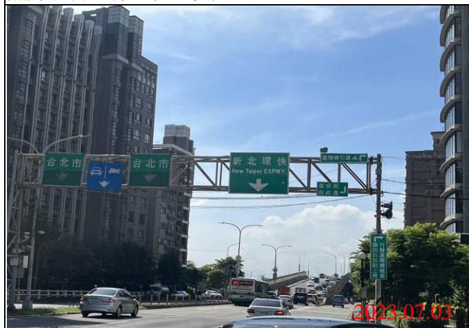
巡查日期地點：112.07.03/ Y23車站 照片說明：牌面設置狀況
