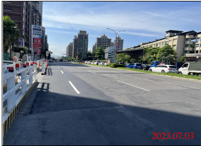
巡查日期地點：112.07.03/ Y23車站 照片說明：路面狀況
