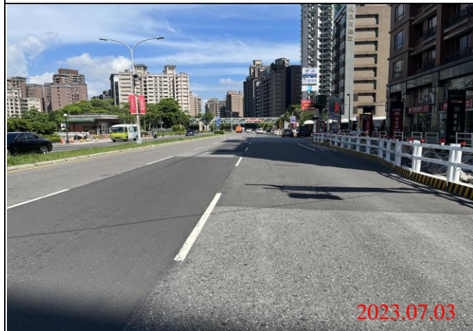
巡查日期地點：112.07.03/ Y23車站 照片說明：路面狀況
