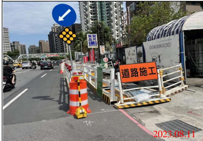
巡查日期地點：112.08.11/ Y23車站 照片說明：牌面設置狀況
