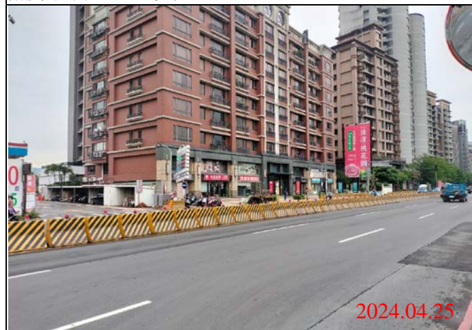
巡查日期地點：113.04.25/ Y23車站 照片說明：路面狀況
