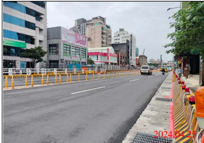
巡查日期地點：113.04.25/ Y21車站 照片說明：路面狀況
