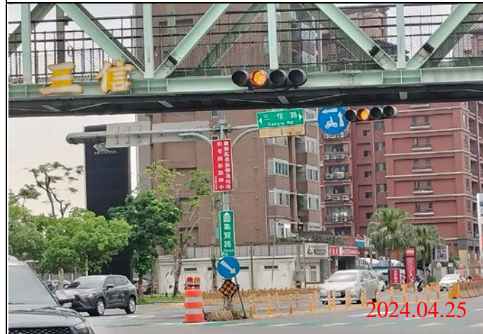
巡查日期地點：113.04.25/ Y23車站 照片說明：牌面設置狀況
