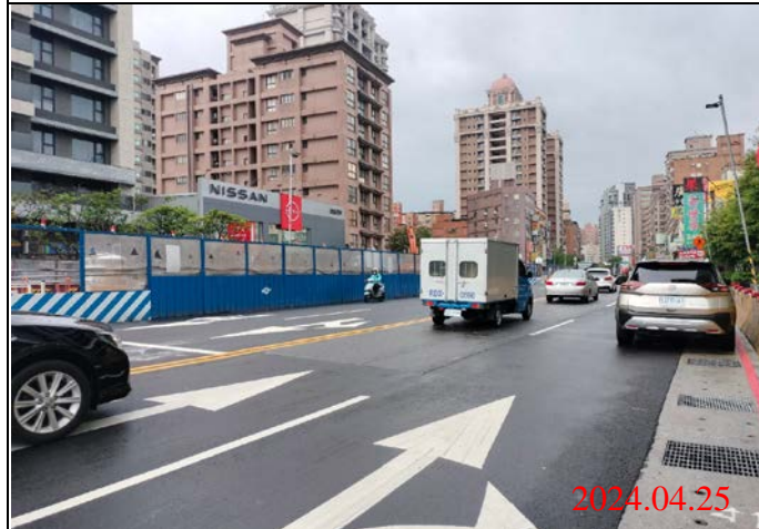
巡查日期地點：113.04.25/ Y22車站 照片說明：路面狀況
