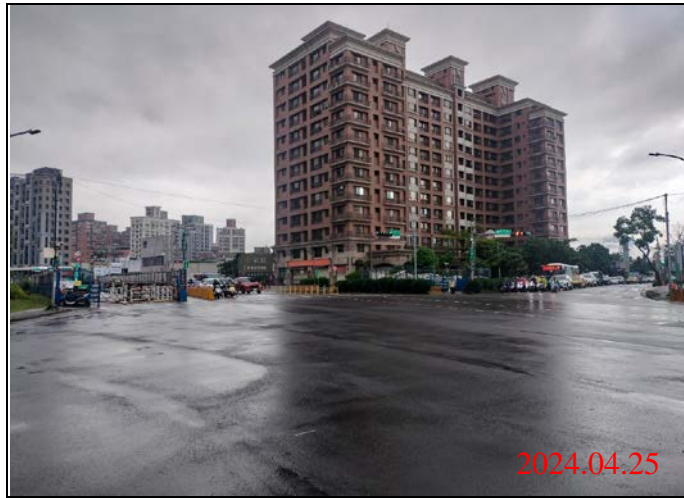
巡查日期地點：113.04.25/ Y22車站 照片說明：路面狀況
