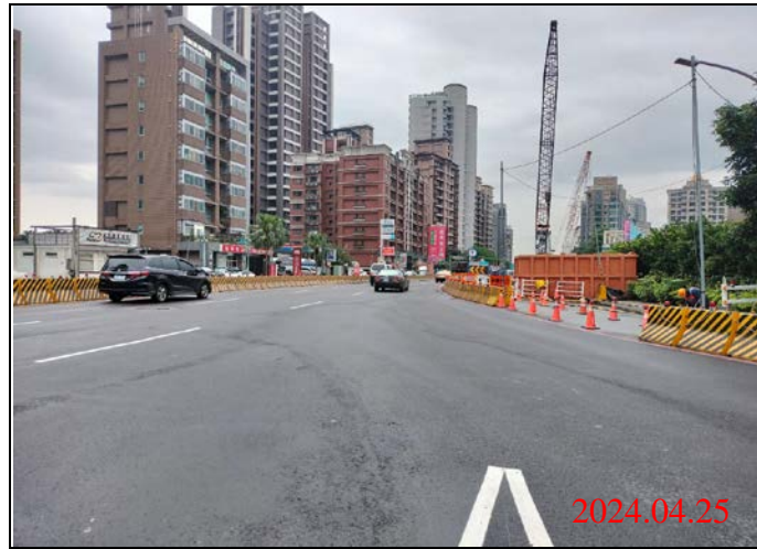
巡查日期地點：113.04.25/ Y23車站 照片說明：路面狀況
