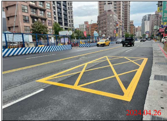
巡查日期地點：113.04.26/ Y22車站 照片說明：路面狀況
