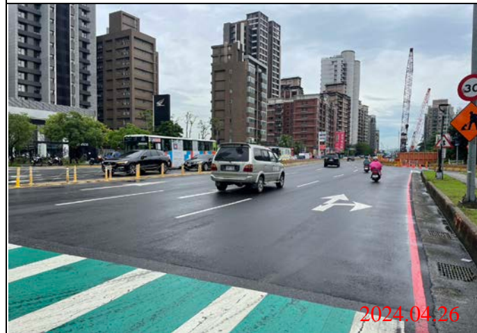
巡查日期地點：113.04.26/ Y23車站 照片說明：路面狀況
