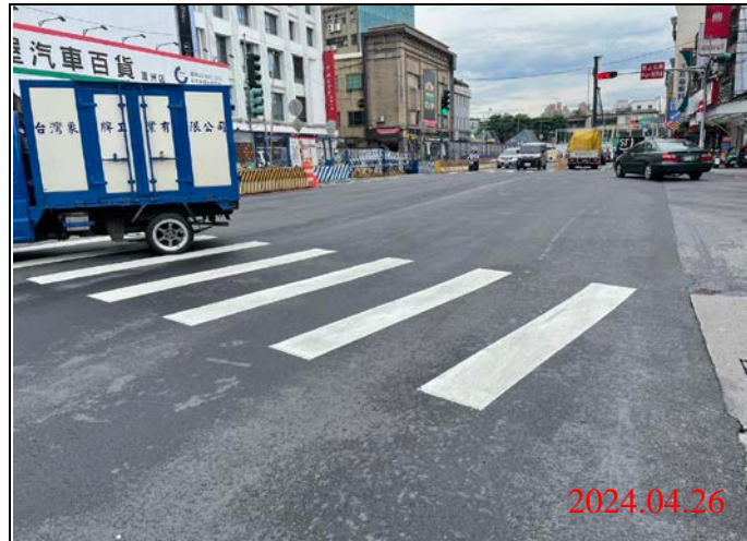
巡查日期地點：113.04.26/ Y21車站 照片說明：路面狀況
