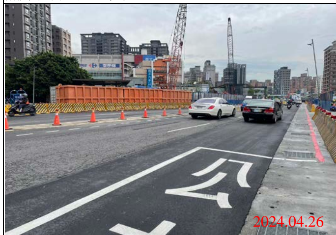
巡查日期地點：113.04.26/ Y22車站 照片說明：路面狀況
