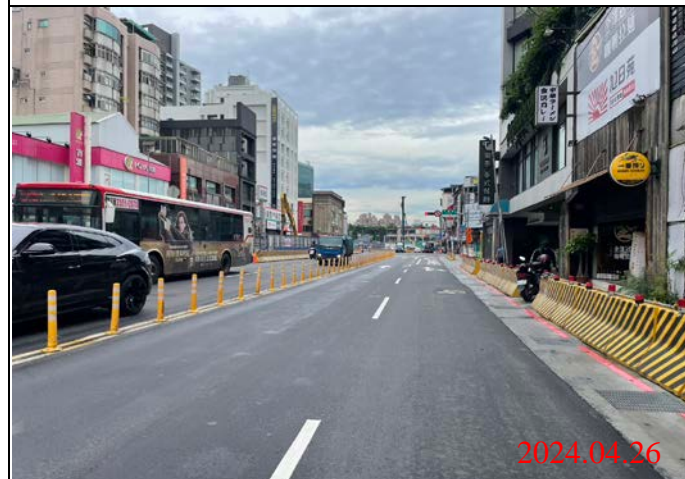
巡查日期地點：113.04.26/ Y21車站 照片說明：路面狀況
