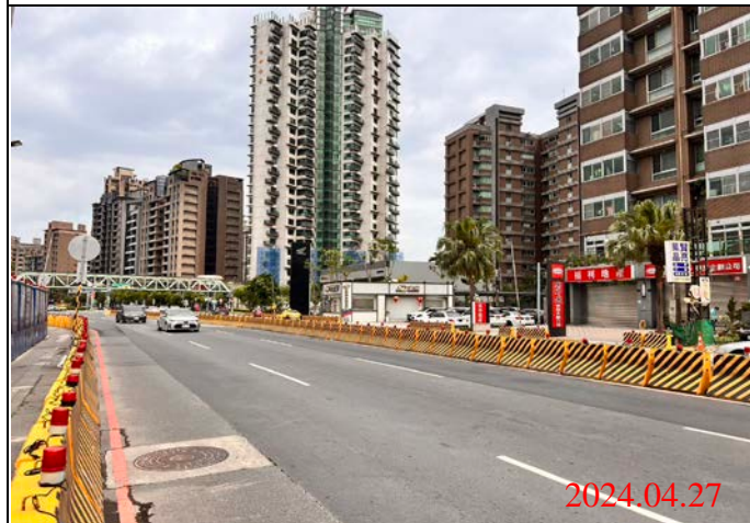
巡查日期地點：113.04.27/ Y23車站 照片說明：路面狀況
