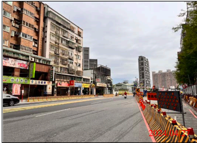
巡查日期地點：113.04.27/ Y22車站 照片說明：路面狀況
