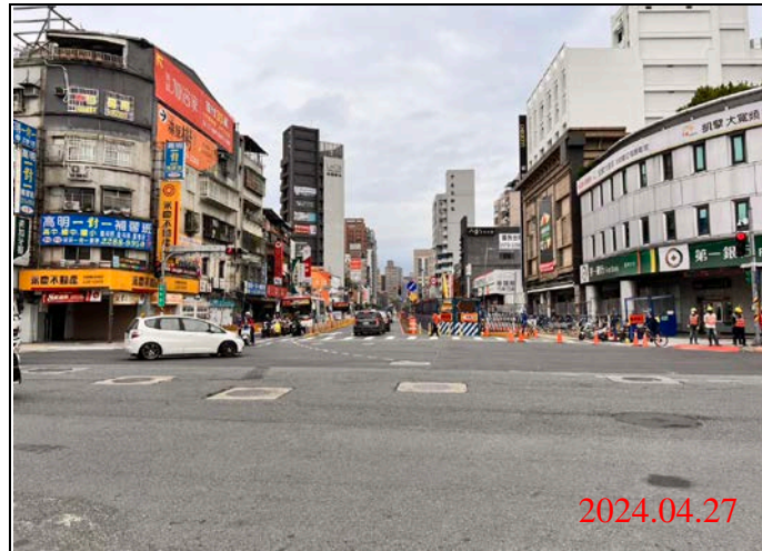
巡查日期地點：113.04.27/ Y21車站 照片說明：路面狀況
