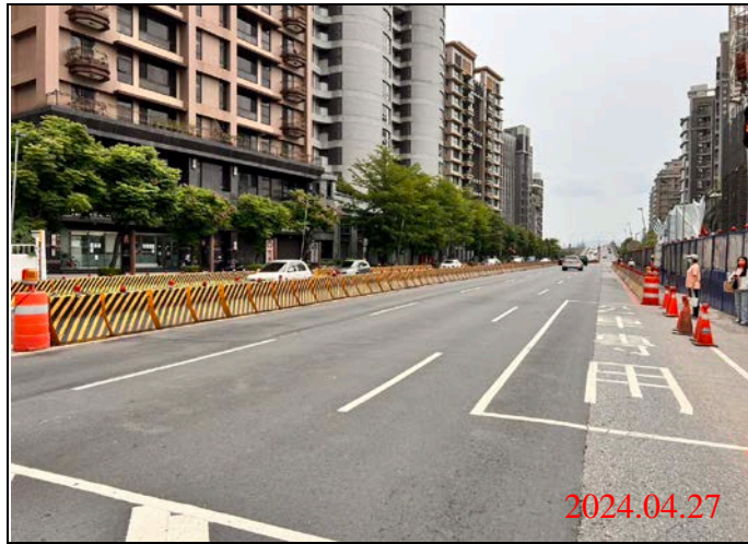
巡查日期地點：113.04.27/ Y23車站 照片說明：路面狀況
