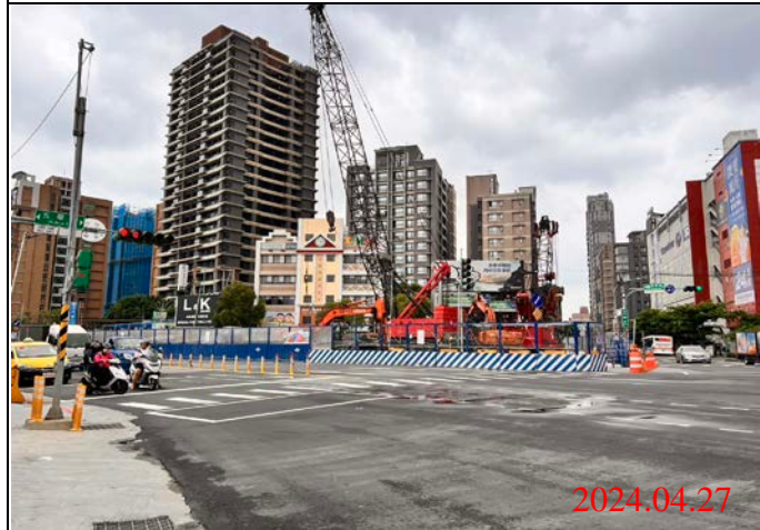
巡查日期地點：113.04.27/ Y22車站 照片說明：路面狀況
