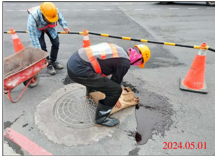
巡查日期地點：113.05.01/ Y23車站 照片說明：Y22路面龜裂修補中
