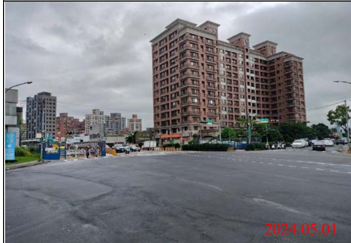
巡查日期地點：113.05.01/ Y22車站 照片說明：路面狀況
