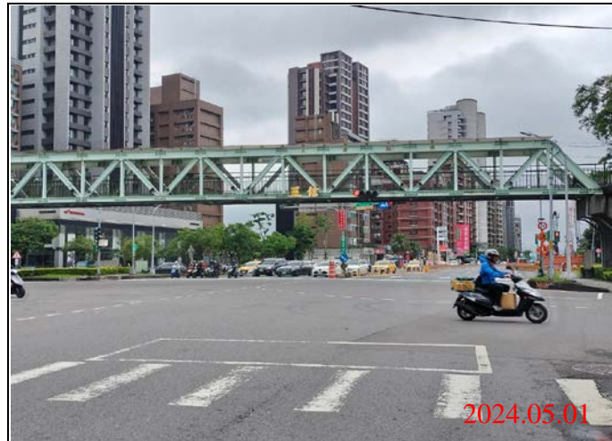
巡查日期地點：113.05.01/ Y23車站 照片說明：路面狀況
