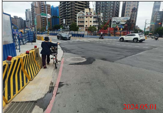
巡查日期地點：113.05.01/ Y23車站 照片說明：Y22路面龜裂修補後
