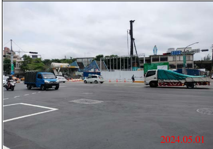
巡查日期地點：113.05.01/ Y21車站 照片說明：路面狀況
