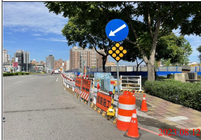
巡查日期地點：112.08.12/ Y22車站 照片說明：牌面設置狀況
