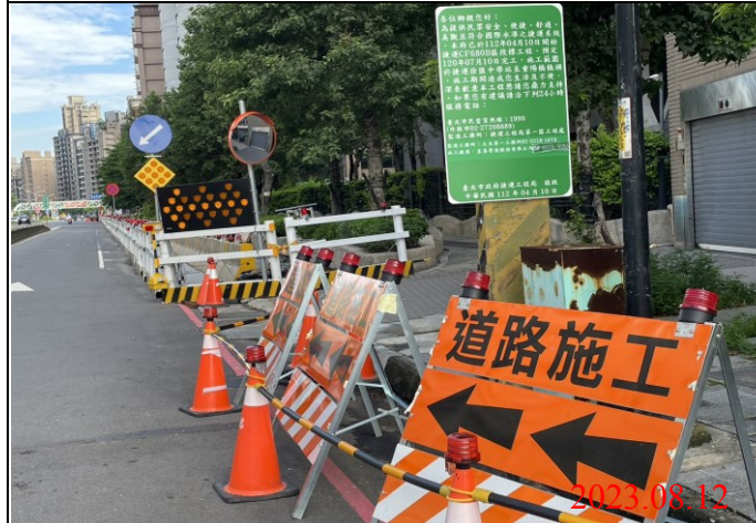
巡查日期地點：112.08.12/ Y23車站 照片說明：牌面設置狀況
