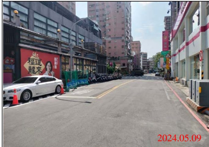
巡查日期地點：113.05.09/ Y21車站 照片說明：路面狀況
