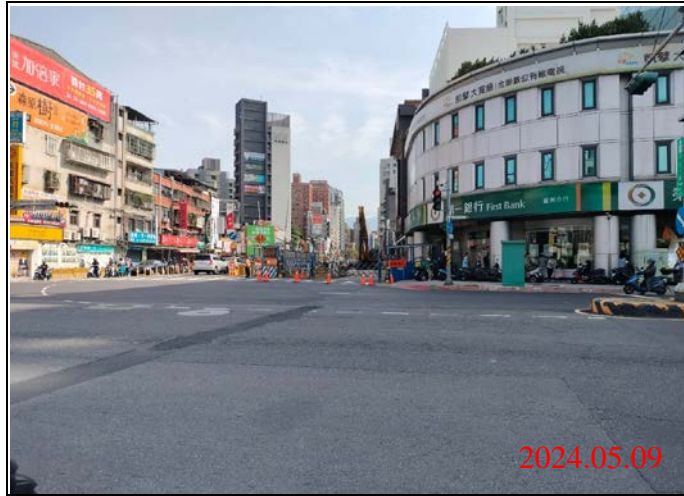
巡查日期地點：113.05.09/ Y21車站 照片說明：路面狀況
