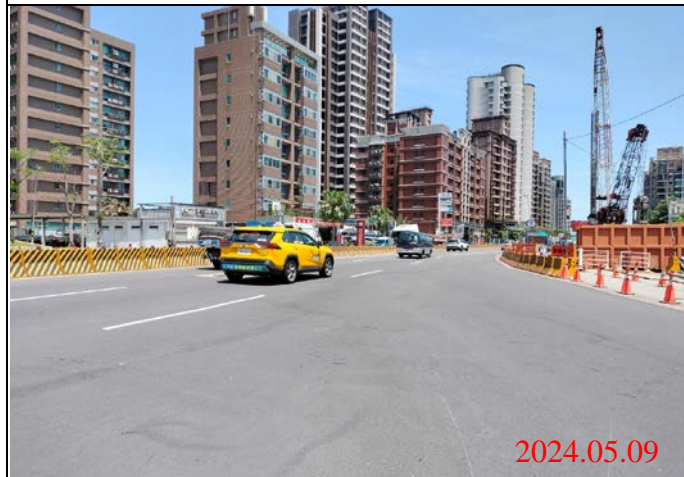
巡查日期地點：113.05.09/ Y23車站 照片說明：路面狀況
