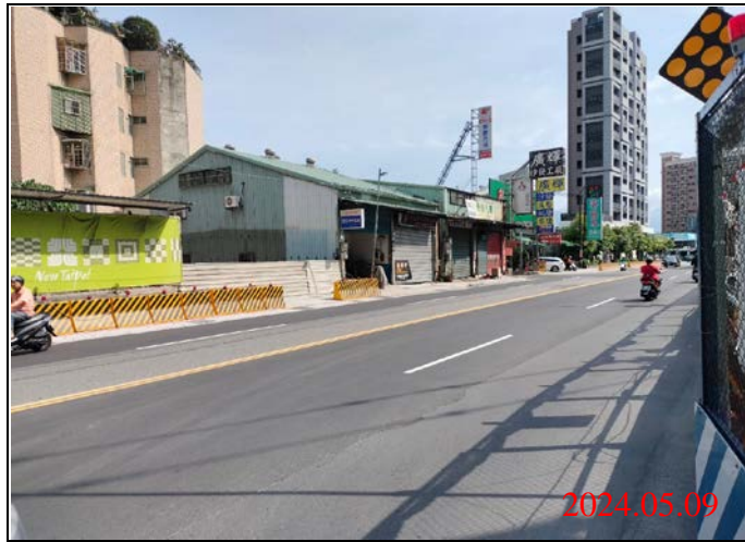
巡查日期地點：113.05.09/ Y22車站 照片說明：路面狀況
