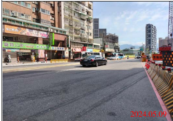
巡查日期地點：113.05.09/ Y22車站 照片說明：路面狀況
