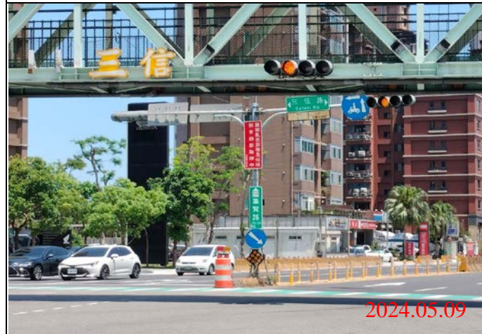
巡查日期地點：113.05.09/ Y23車站 照片說明：牌面設置狀況
