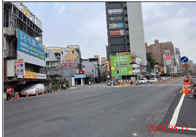
巡查日期地點：113.05.11/ Y21車站 照片說明：路面狀況
