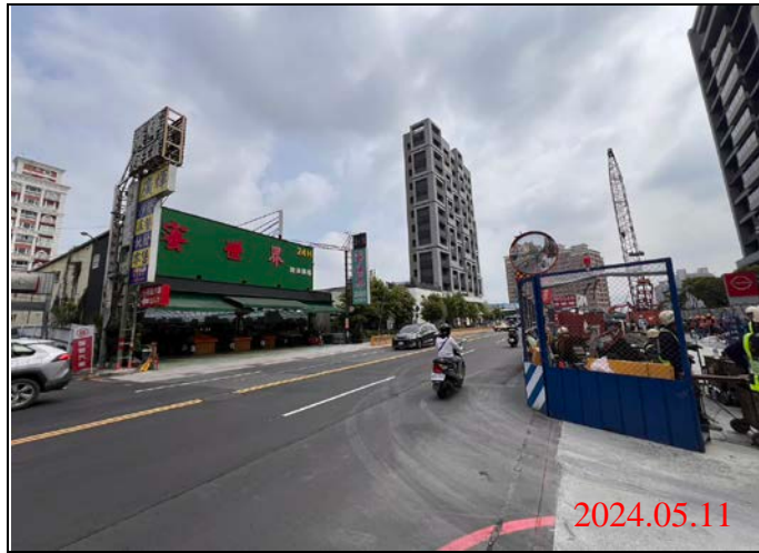
巡查日期地點：113.05.11/ Y22車站 照片說明：路面狀況
