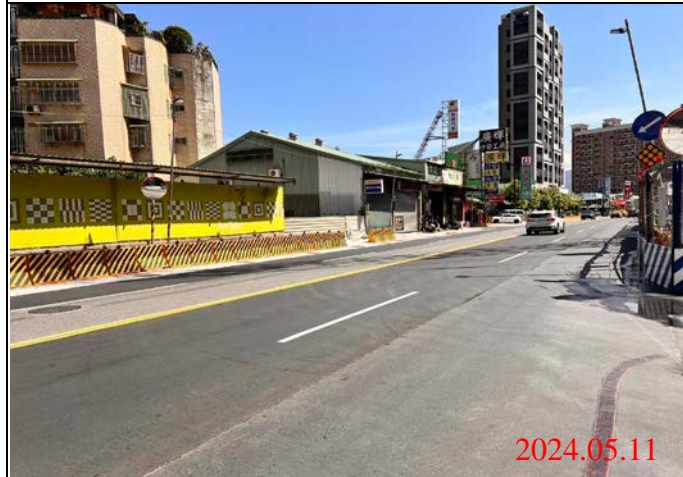
巡查日期地點：113.05.11/ Y22車站 照片說明：路面狀況
