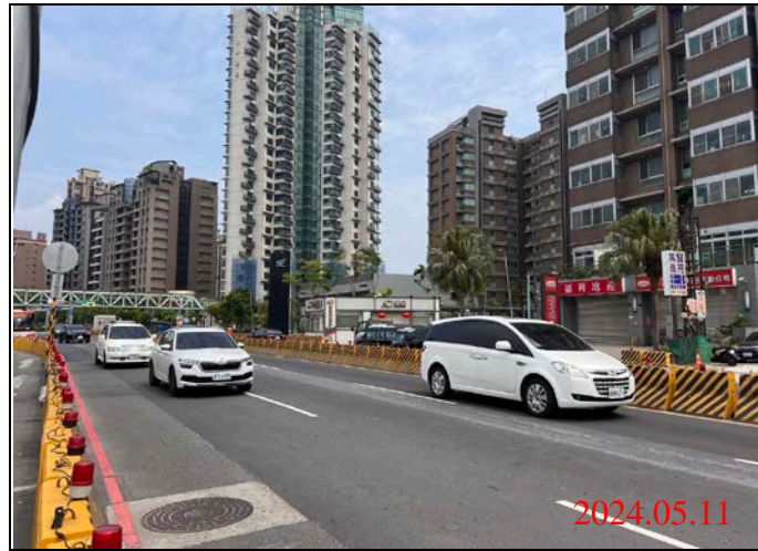
巡查日期地點：113.05.11/ Y23車站 照片說明：路面狀況
