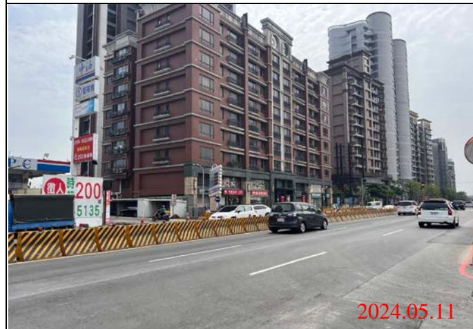
巡查日期地點：113.05.11/ Y23車站 照片說明：路面狀況
