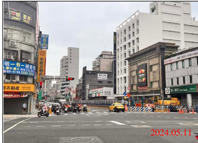
巡查日期地點：113.05.11/ Y21車站 照片說明：路面狀況
