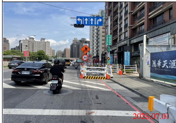
巡查日期地點：112.07.01/ Y23車站 照片說明：牌面設置狀況
