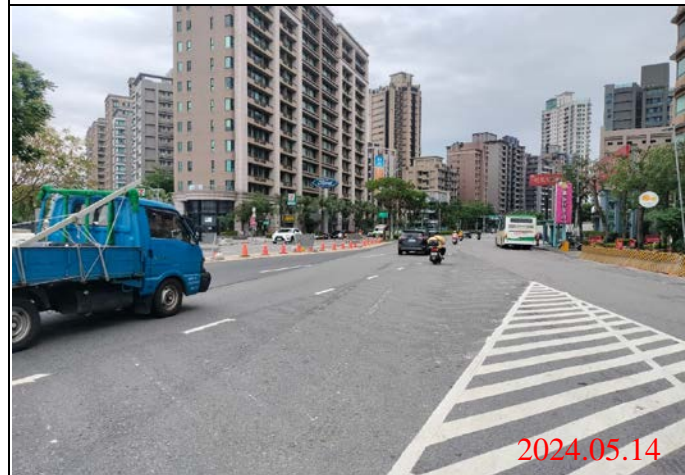
巡查日期地點：113.05.14/ Y22車站 照片說明：路面狀況
