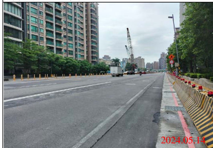
巡查日期地點：113.05.14/ Y23車站 照片說明：路面狀況
