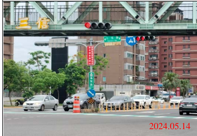
巡查日期地點：113.05.14/ Y23車站 照片說明：牌面設置狀況
