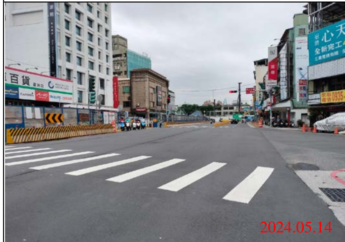
巡查日期地點：113.05.14/ Y21車站 照片說明：路面狀況
