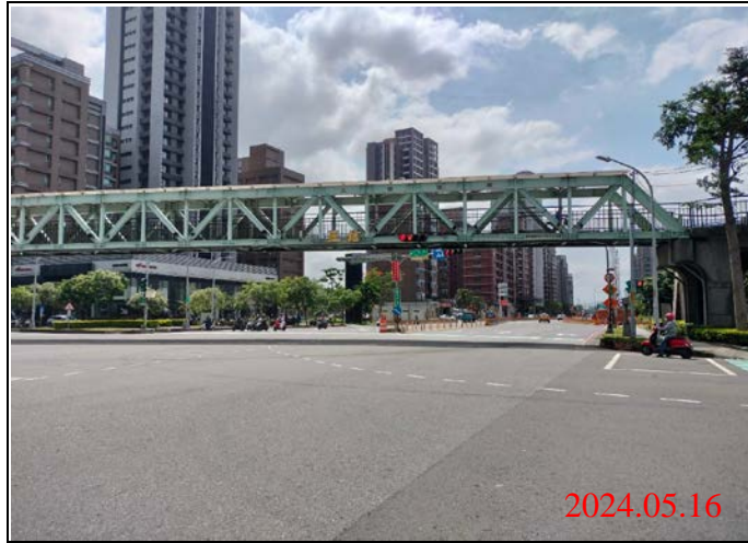
巡查日期地點：113.05.16/ Y23車站 照片說明：路面狀況
