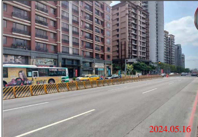
巡查日期地點：113.05.16/ Y23車站 照片說明：路面狀況
