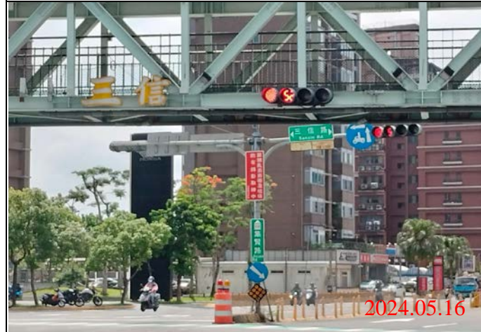
巡查日期地點：113.05.16/ Y23車站 照片說明：牌面設置狀況
