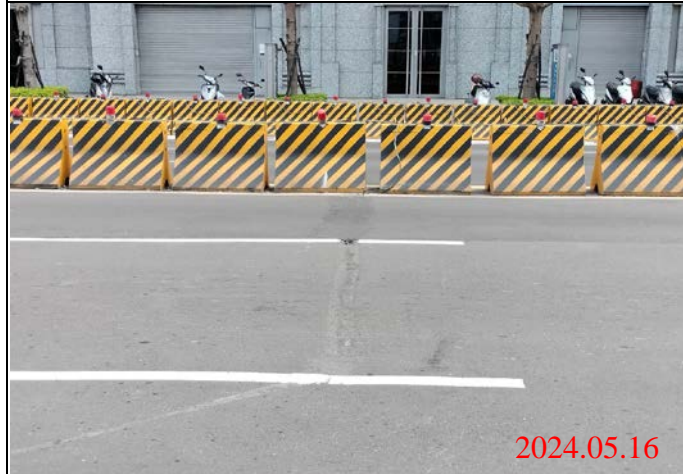
巡查日期地點：113.05.16/ Y23車站 照片說明：南側道路坑洞
