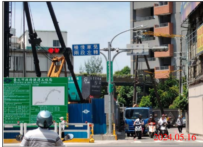
巡查日期地點：113.05.16/ Y21車站 照片說明：牌面設置狀況
