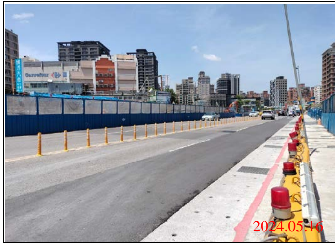
巡查日期地點：113.05.16/ Y22車站 照片說明：路面狀況
