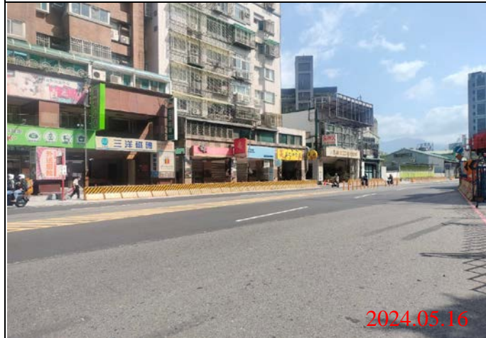
巡查日期地點：113.05.16/ Y22車站 照片說明：路面狀況
