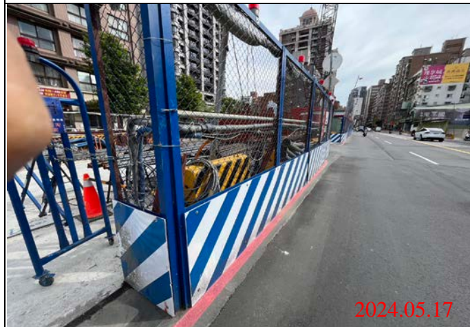
巡查日期地點：113.05.17/ Y22車站 照片說明：路面狀況
