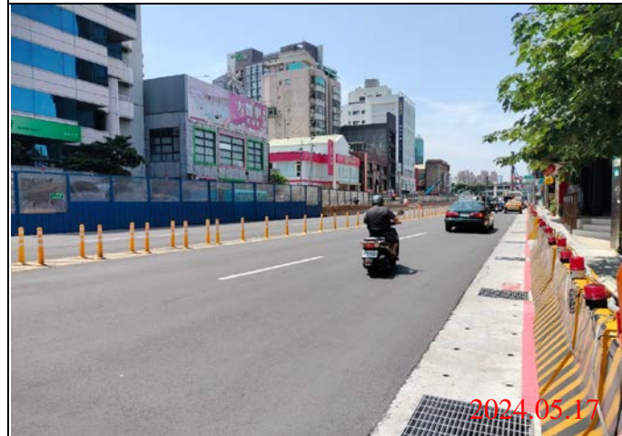
巡查日期地點：113.05.17/ Y21車站 照片說明：路面狀況
