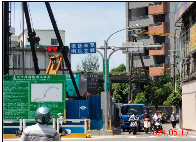
巡查日期地點：113.05.17/ Y21車站 照片說明：牌面設置狀況
