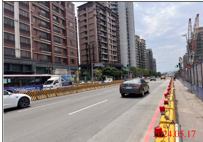
巡查日期地點：113.05.17/ Y23車站 照片說明：路面狀況
