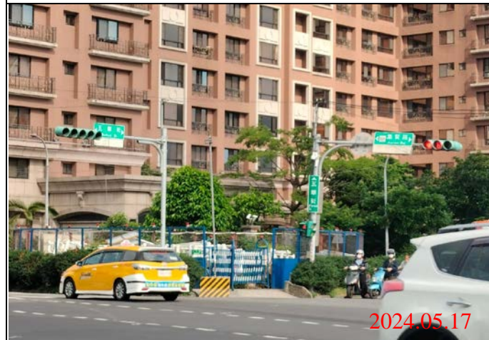
巡查日期地點：113.05.17/ Y22車站 照片說明：牌面設置狀況
