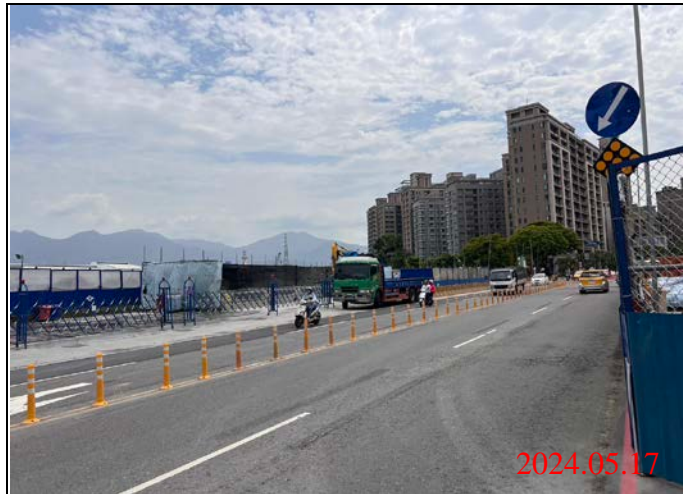
巡查日期地點：113.05.17/ Y22車站 照片說明：路面狀況
