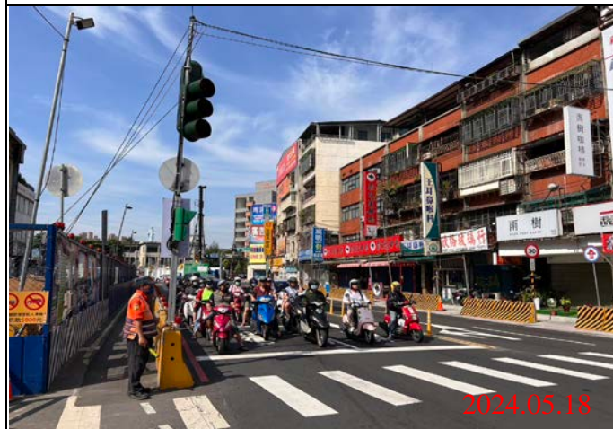
巡查日期地點：113.05.18/ Y21車站 照片說明：路面狀況
