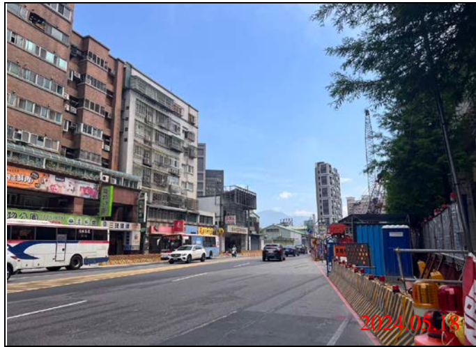
巡查日期地點：113.05.18/ Y22車站 照片說明：路面狀況
