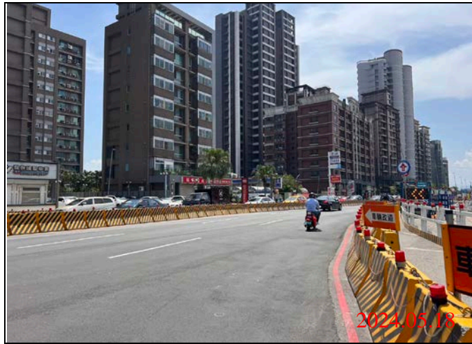
巡查日期地點：113.05.18/ Y23車站 照片說明：路面狀況
