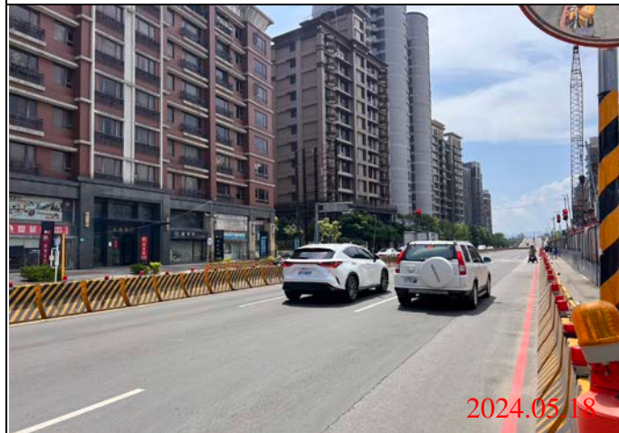
巡查日期地點：113.05.18/ Y23車站 照片說明：路面狀況
