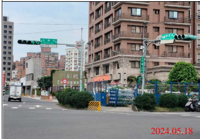
巡查日期地點：113.05.18/ Y22車站 照片說明：路面狀況
