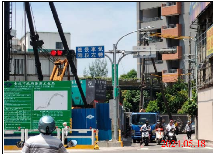
巡查日期地點：113.05.18/ Y21車站 照片說明：牌面設置狀況
