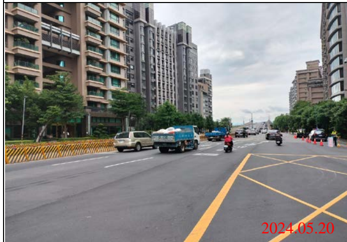
巡查日期地點：113.05.20/ Y23車站 照片說明：路面狀況
