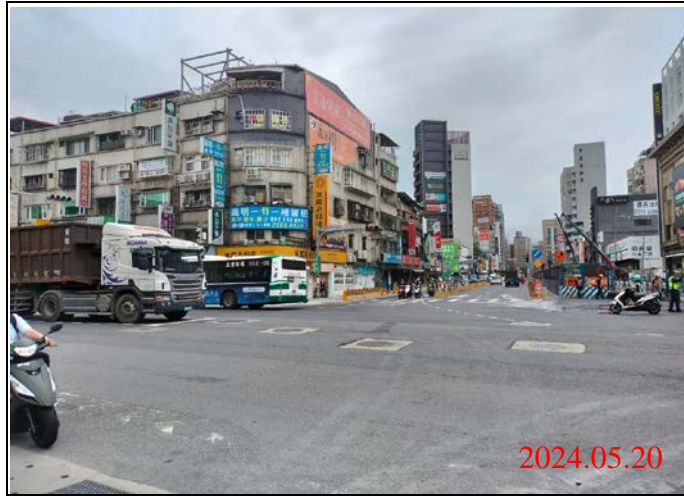
巡查日期地點：113.05.20/ Y21車站 照片說明：路面狀況
