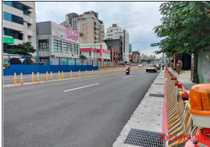
巡查日期地點：113.05.20/ Y21車站 照片說明：路面狀況
