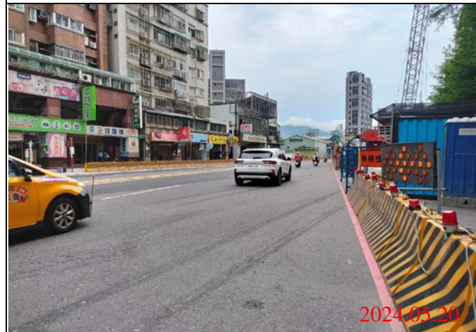
巡查日期地點：113.05.20/ Y22車站 照片說明：路面狀況
