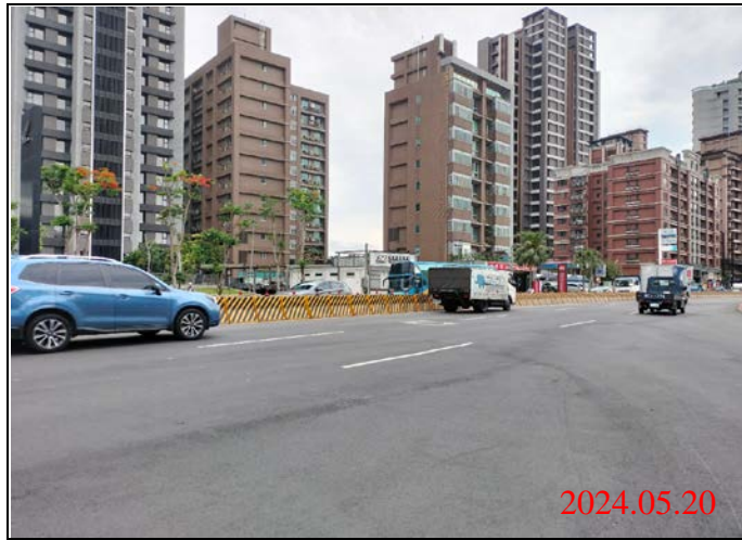
巡查日期地點：113.05.20/-23車站 照片說明：路面狀況
