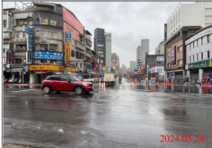
巡查日期地點：113.05.24/ Y21車站 照片說明：路面狀況
