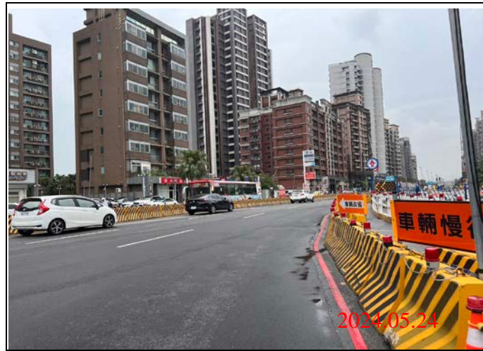
巡查日期地點：113.05.24/-24車站 照片說明：路面狀況
