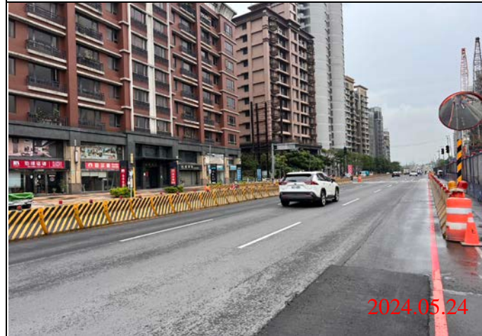
巡查日期地點：113.05.24/ Y24車站 照片說明：路面狀況
