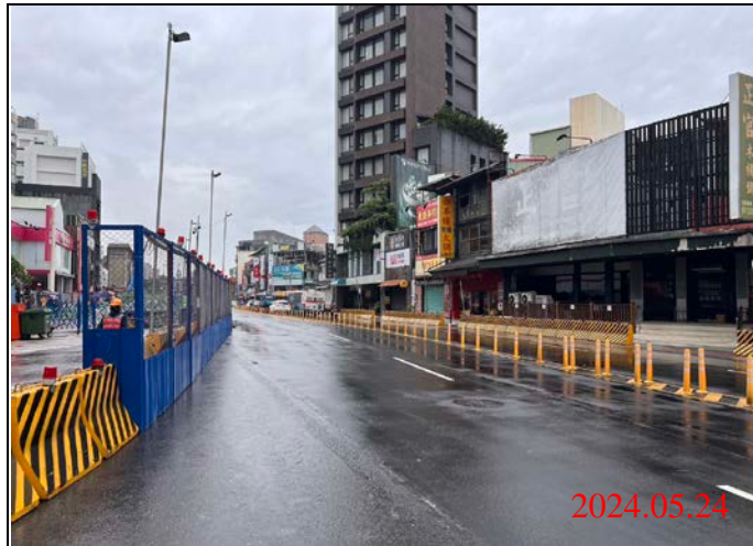
巡查日期地點：113.05.24/ Y21車站 照片說明：路面狀況
