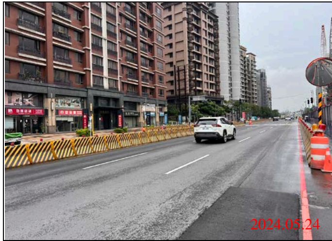
巡查日期地點：113.05.24/ Y22車站 照片說明：路面狀況
