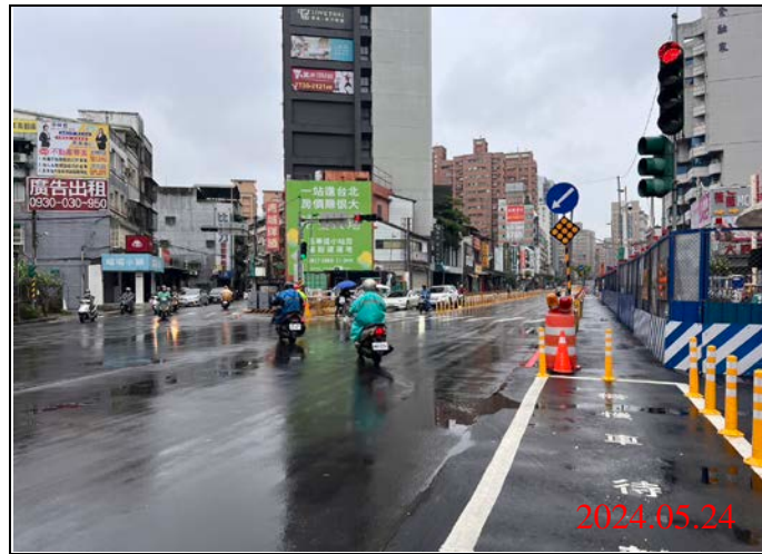
巡查日期地點：113.05.24/ Y21車站 照片說明：牌面設置狀況
