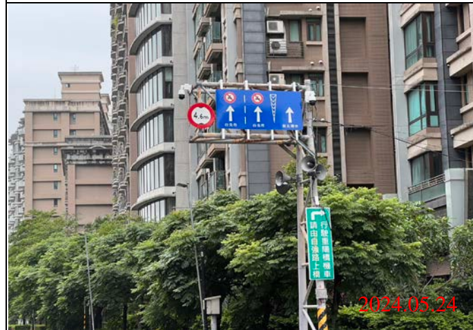
巡查日期地點：113.05.24/ Y24車站 照片說明：牌面設置狀況
