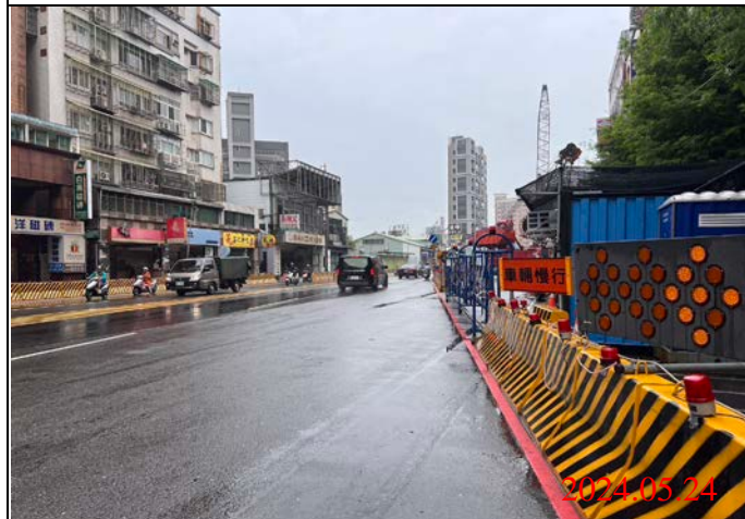
巡查日期地點：113.05.24/ Y22車站 照片說明：路面狀況
