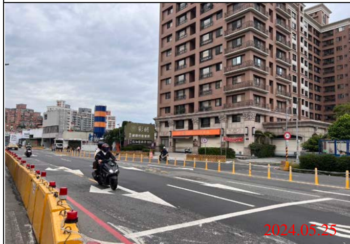
巡查日期地點：113.05.25/ Y22車站 照片說明：路面狀況
