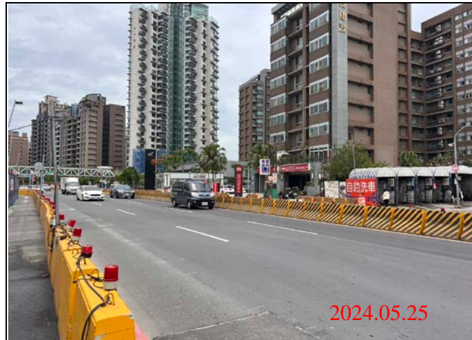
巡查日期地點：113.05.25/23車站 照片說明：路面狀況
