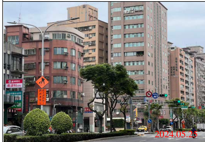
巡查日期地點：113.05.25/ Y22車站 照片說明：牌面設置狀況
