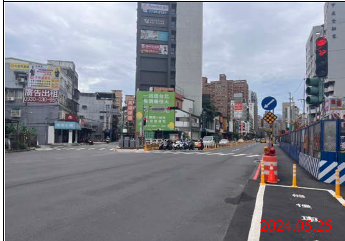
巡查日期地點：113.05.25/ Y21車站 照片說明：路面狀況
