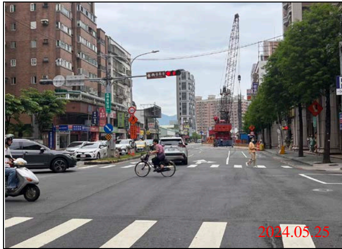
巡查日期地點：113.05.25/ Y22車站 照片說明：路面狀況
