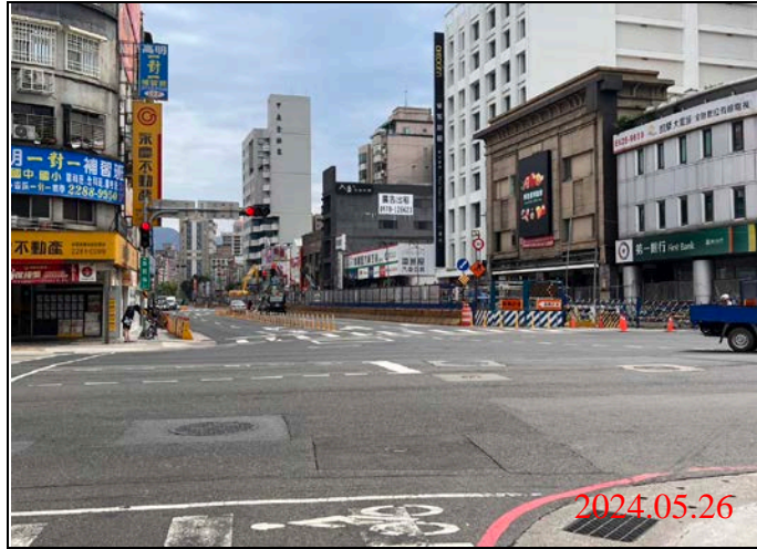
巡查日期地點：113.05.26/ Y21車站 照片說明：路面狀況
