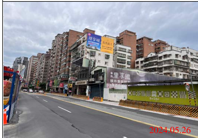
巡查日期地點：113.05.26/ Y22車站 照片說明：路面狀況
