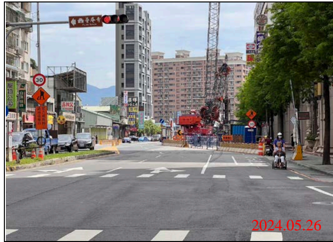
巡查日期地點：113.05.26/ Y22車站 照片說明：路面狀況
