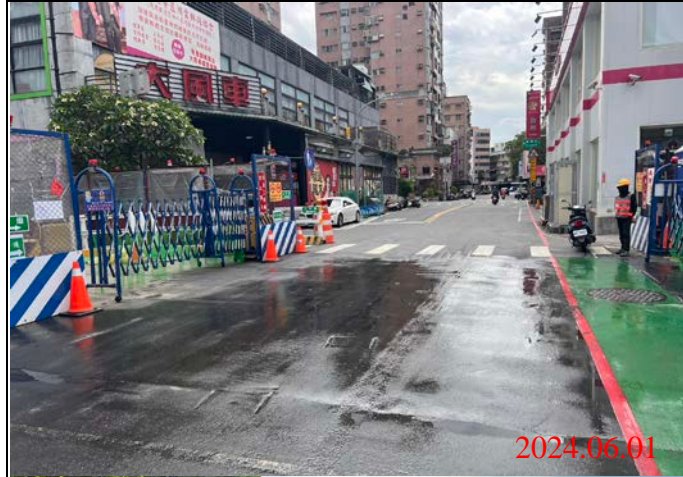
巡查日期地點：113.06.01/ Y21車站 照片說明：路面狀況
