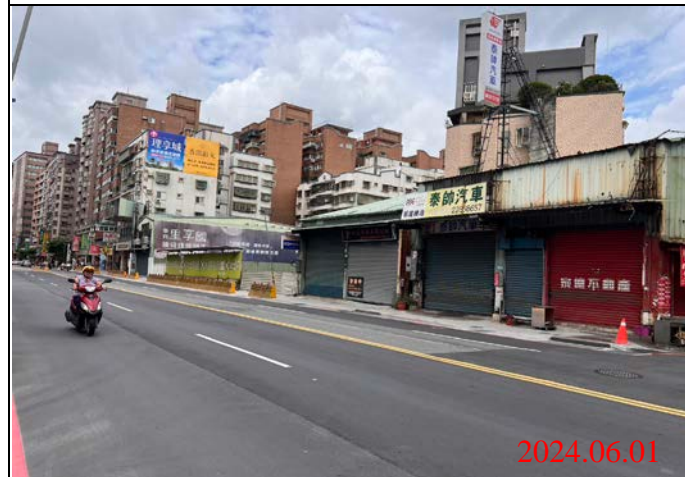
巡查日期地點：113.06.01/ Y22車站 照片說明：路面狀況
