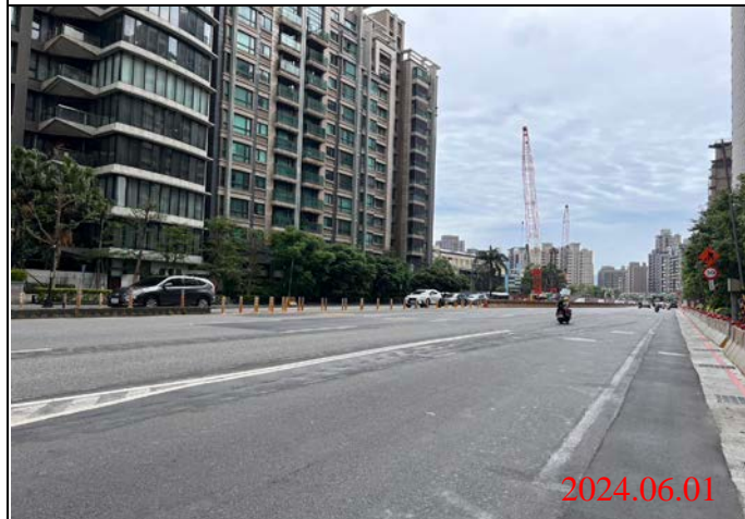
巡查日期地點：113.06.01/ Y23車站 照片說明：路面狀況
