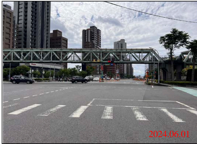
巡查日期地點：113.06.01/-23車站 照片說明：路面狀況
