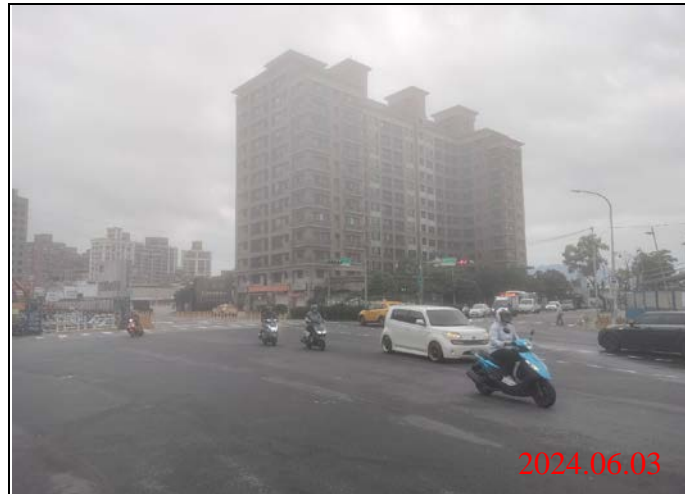
巡查日期地點：113.06.03/ Y22車站 照片說明：路面狀況
