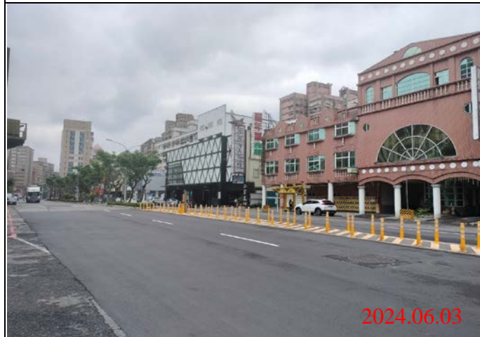
巡查日期地點：113.06.03/ Y21車站 照片說明：路面狀況
