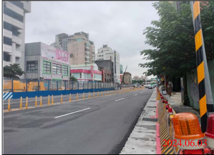
巡查日期地點：113.06.03/ Y21車站 照片說明：路面狀況
