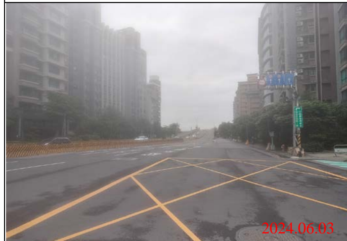
巡查日期地點：113.06.03/ Y23車站 照片說明：路面狀況
