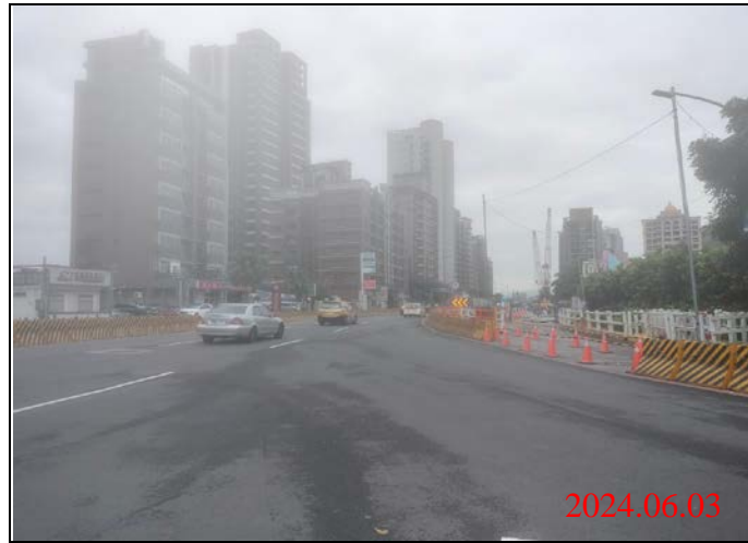
巡查日期地點：113.06.03/-23車站 照片說明：路面狀況
