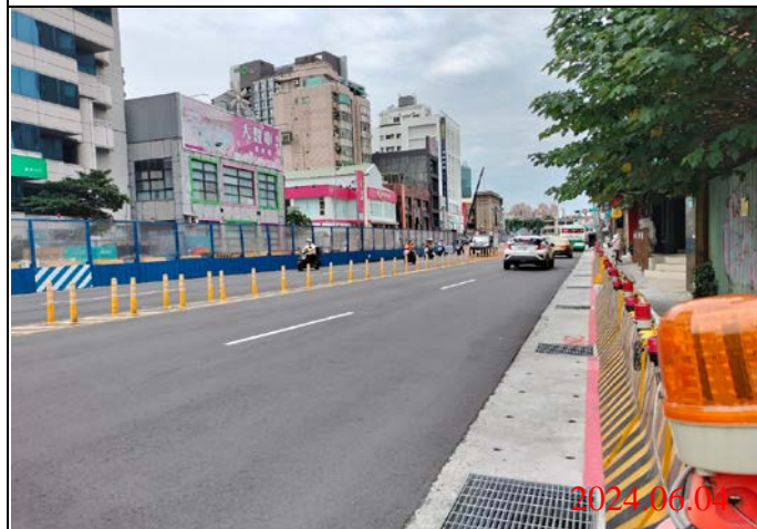
巡查日期地點：113.06.04/ Y21車站 照片說明：路面狀況
