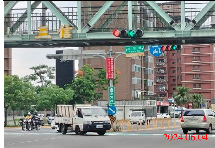
巡查日期地點：113.06.04/ Y23車站 照片說明：牌面設置狀況
