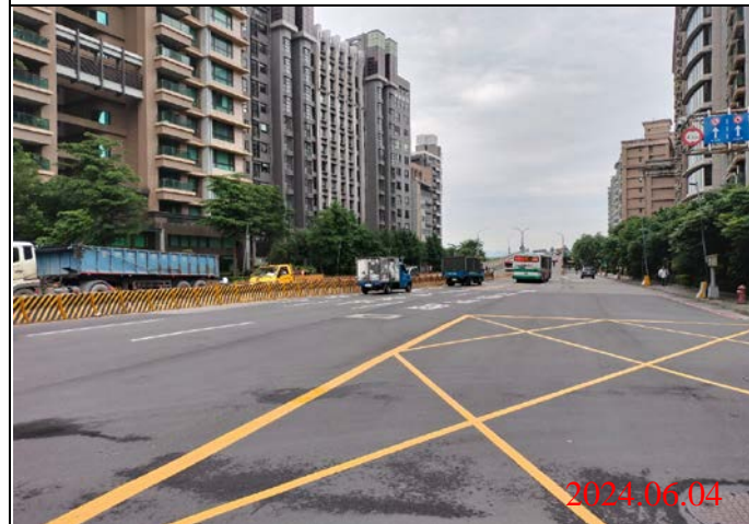
巡查日期地點：113.06.04/ Y23車站 照片說明：路面狀況
