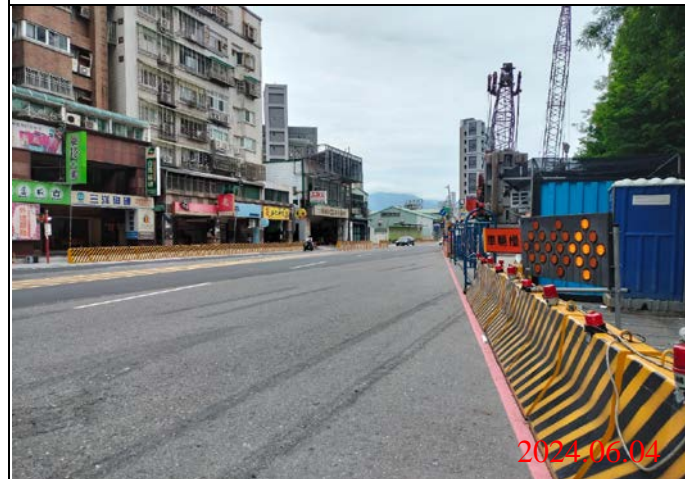
巡查日期地點：113.06.04/ Y22車站 照片說明：路面狀況
