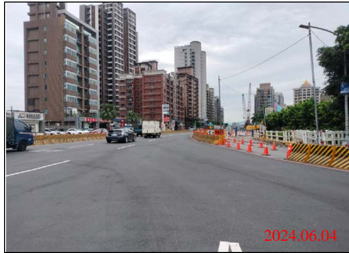
巡查日期地點：113.06.04/-23車站 照片說明：路面狀況
