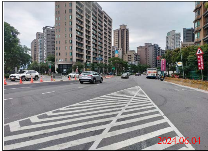
巡查日期地點：113.06.04/ Y22車站 照片說明：路面狀況
