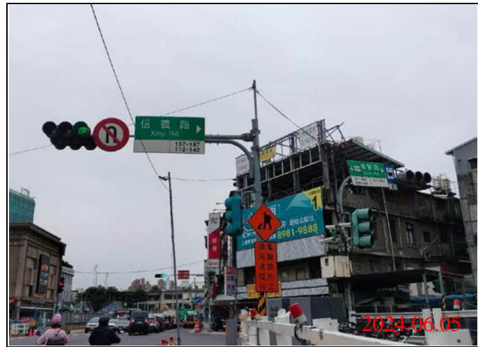
巡查日期地點：113.06.05/ Y21車站 照片說明：牌面設置狀況
