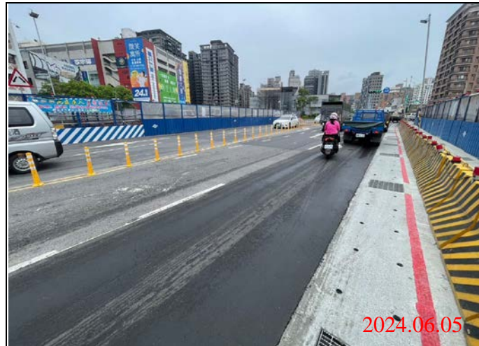
巡查日期地點：113.06.05/ Y22車站 照片說明：路面狀況
