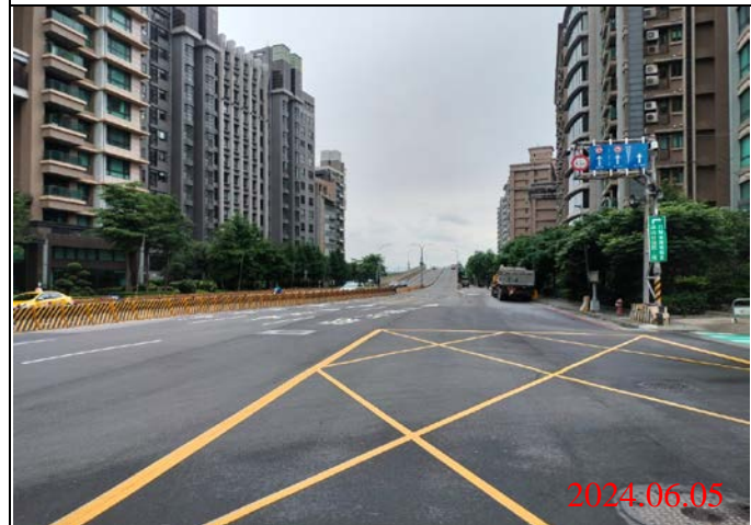
巡查日期地點：113.06.05/ Y23車站 照片說明：路面狀況
