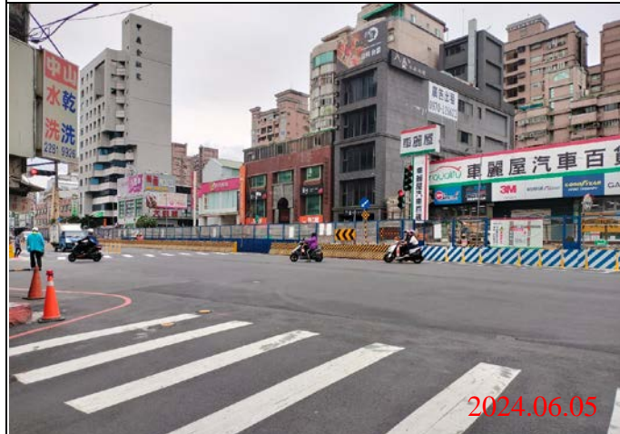
巡查日期地點：113.06.05/ Y21車站 照片說明：路面狀況
