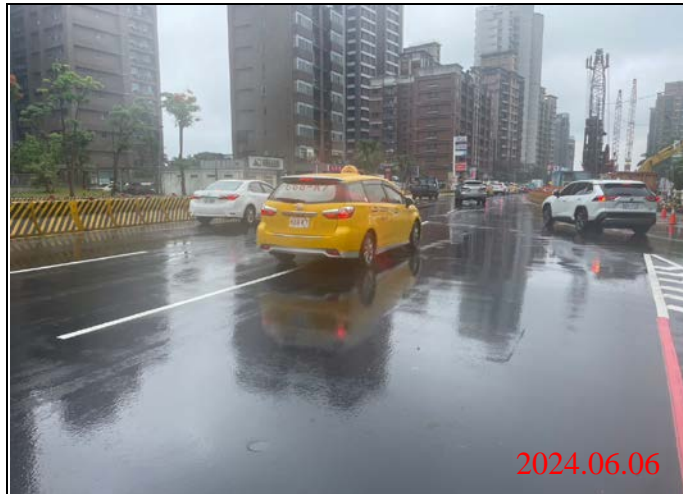
巡查日期地點：113.06.06/ Y23車站 照片說明：路面狀況
