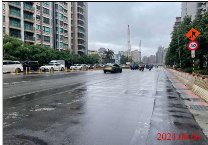
巡查日期地點：113.06.06/ Y23車站 照片說明：路面狀況
