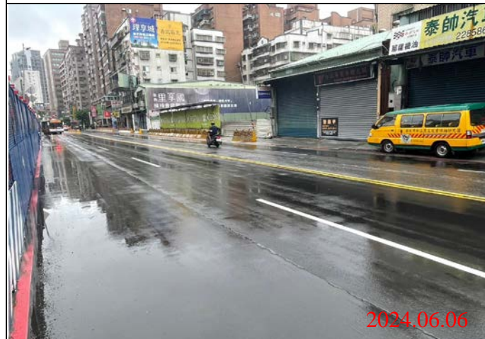
巡查日期地點：113.06.06/ Y22車站 照片說明：路面狀況
