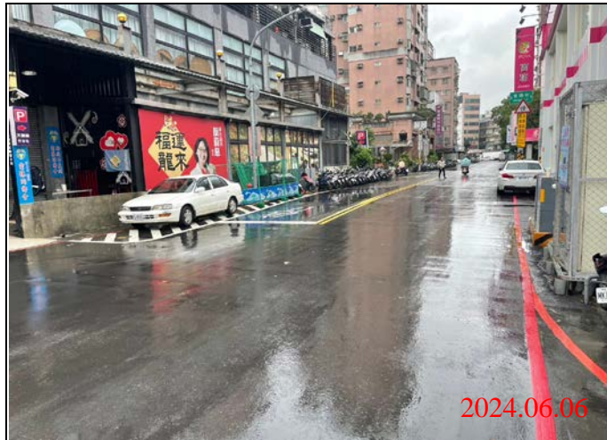
巡查日期地點：113.06.06/ Y21車站 照片說明：路面狀況
