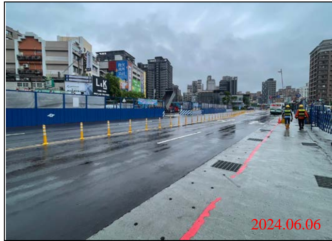
巡查日期地點：113.06.06/ Y22車站 照片說明：路面狀況
