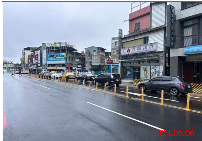
巡查日期地點：113.06.06/ Y21車站 照片說明：路面狀況
