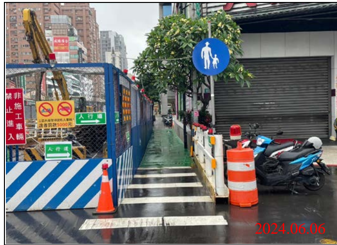
巡查日期地點：113.06.06/ Y21車站 照片說明：牌面設置狀況
