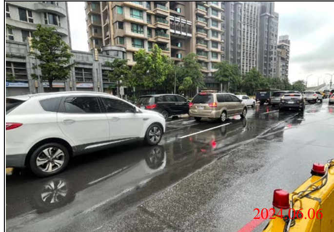
巡查日期地點：113.06.06/ Y23車站 照片說明：路面損壞情況
