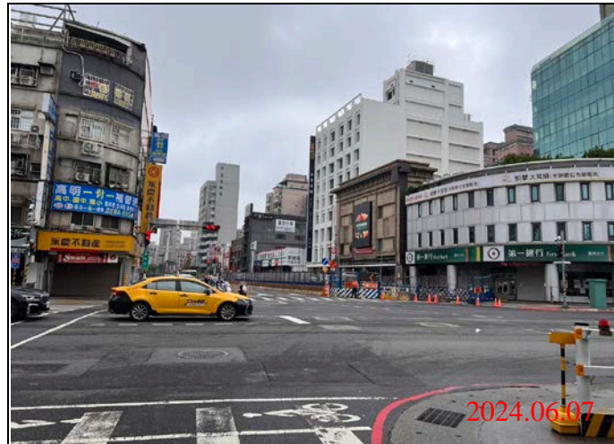
巡查日期地點：113.06.07/ Y21車站 照片說明：路面狀況
