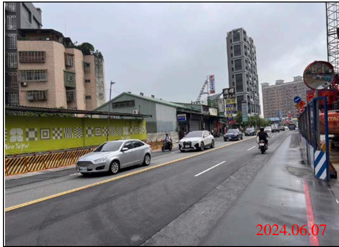
巡查日期地點：113.06.07/ Y22車站 照片說明：路面狀況
