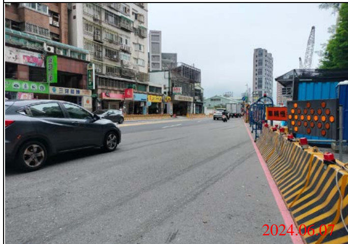
巡查日期地點：113.06.07/ Y22車站 照片說明：路面狀況
