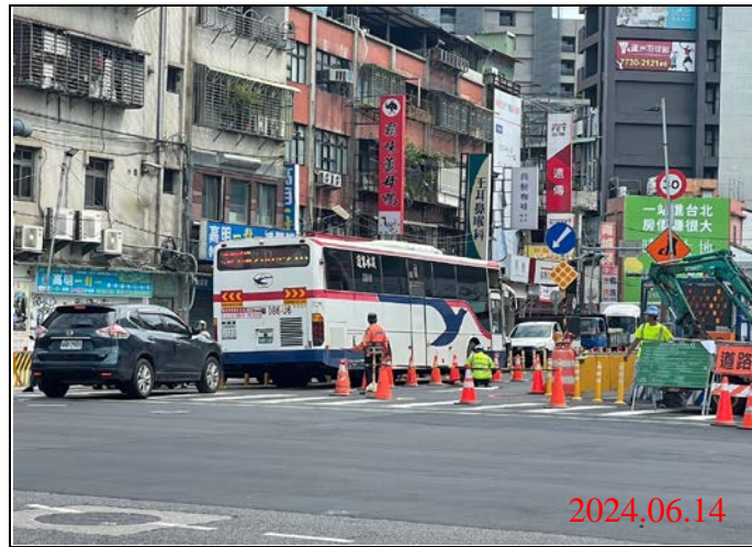
巡查日期地點：1137.06.14/ Y21車站 照片說明：牌面設置狀況
