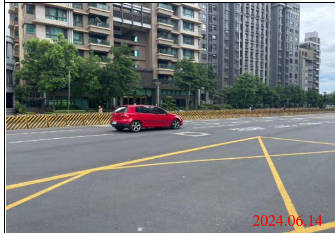
巡查日期地點：113.06.14/ Y23車站 照片說明：路面狀況
