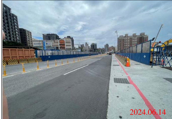
巡查日期地點：113.06.14/ Y22車站 照片說明：路面狀況
