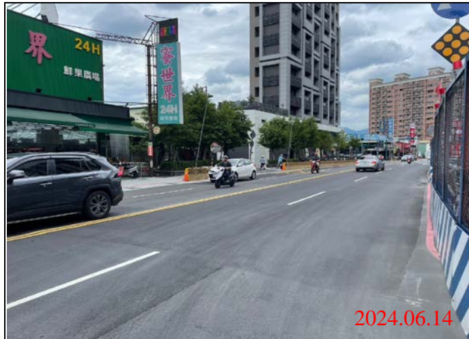
巡查日期地點：113.06.14/ Y22車站 照片說明：路面狀況
