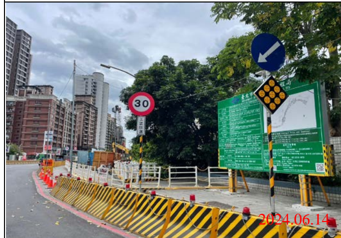
巡查日期地點：113.06.14/ Y23車站 照片說明：牌面設置狀況
