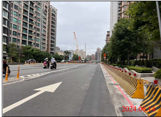
巡查日期地點：113.06.14/-23車站 照片說明：路面狀況
