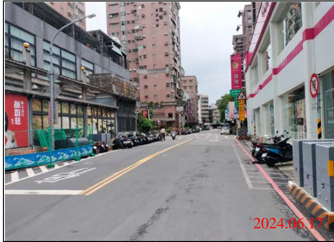
巡查日期地點：113.06.17/ Y21車站 照片說明：路面狀況
