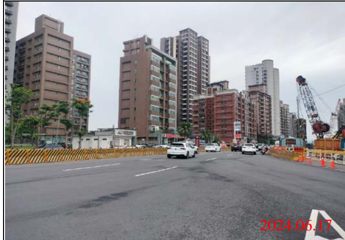
巡查日期地點：113.06.17/ Y23車站 照片說明：路面狀況
