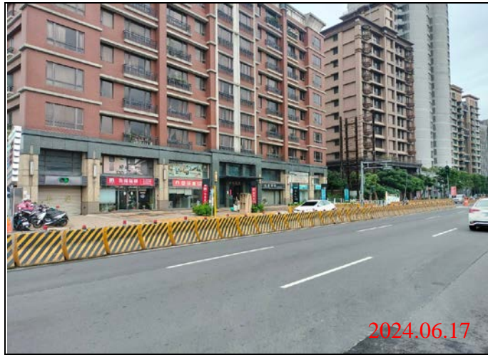
巡查日期地點：113.06.17/-23車站 照片說明：路面狀況
