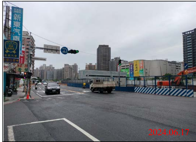
巡查日期地點：113.06.17/ Y22車站 照片說明：路面狀況
