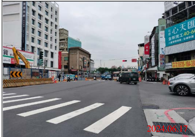
巡查日期地點：113.06.17/ Y21車站 照片說明：路面狀況
