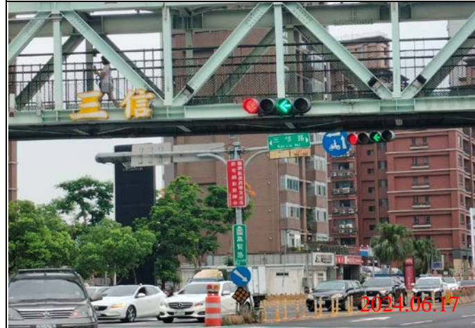
巡查日期地點：113.06.17/ Y23車站 照片說明：牌面設置狀況
