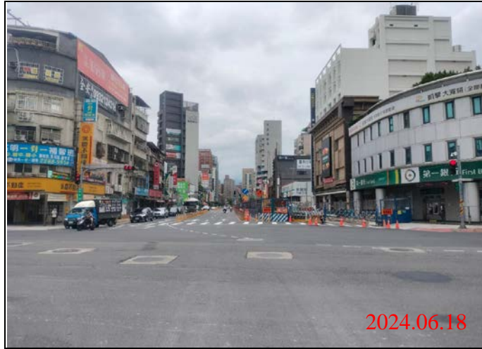
巡查日期地點：113.06.18/ Y21車站 照片說明：路面狀況
