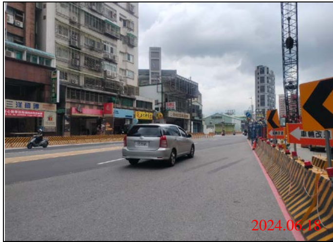
巡查日期地點：113.06.18/ Y22車站 照片說明：路面狀況
