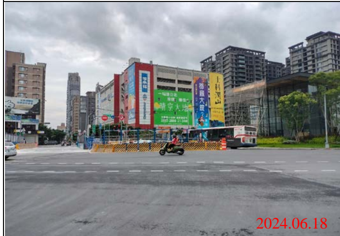
巡查日期地點：113.06.18/ Y22車站 照片說明：路面狀況
