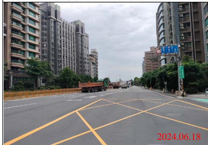
巡查日期地點：113.06.18/ Y23車站 照片說明：路面狀況
