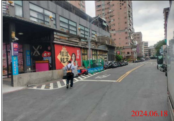
巡查日期地點：113.06.18/ Y21車站 照片說明：路面狀況
