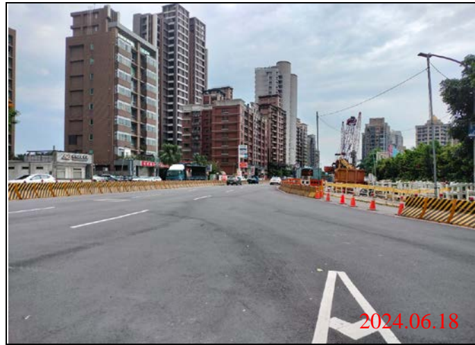
巡查日期地點：113.06.18/-23車站 照片說明：路面狀況
