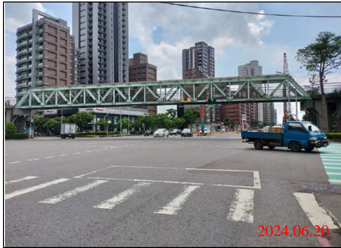
巡查日期地點：113.06.10/23車站 照片說明：路面狀況
