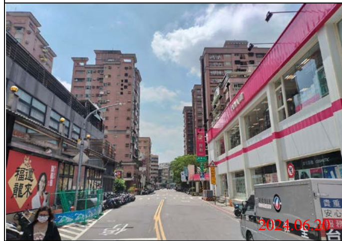
巡查日期地點：113.06.20/ Y21車站 照片說明：路面狀況
