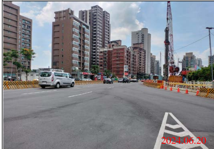
巡查日期地點：113.06.20/Y23車站 照片說明：路面狀況
