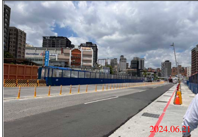
巡查日期地點：113.06.21/ Y22車站 照片說明：路面狀況
