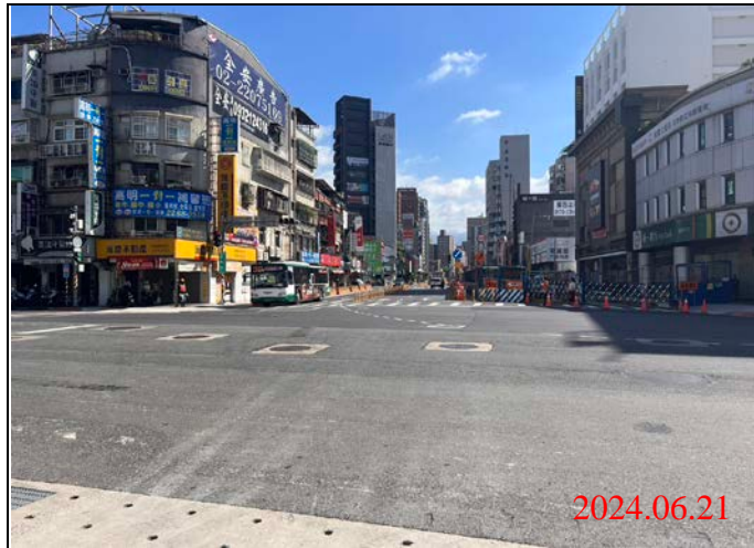
巡查日期地點：113.06.21/ Y21車站 照片說明：路面狀況
