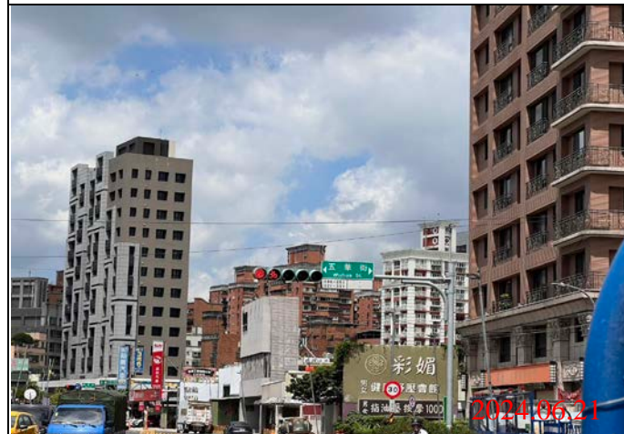
巡查日期地點：113.06.21/ Y22車站 照片說明：牌面設置狀況
