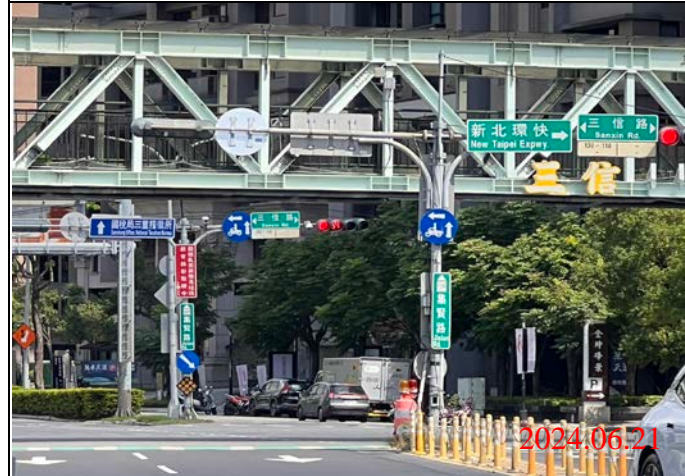
巡查日期地點：113.06.21/ Y23車站 照片說明：牌面設置狀況
