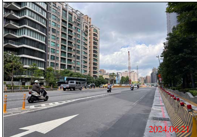
巡查日期地點：113.06.21/ Y23車站 照片說明：路面狀況
