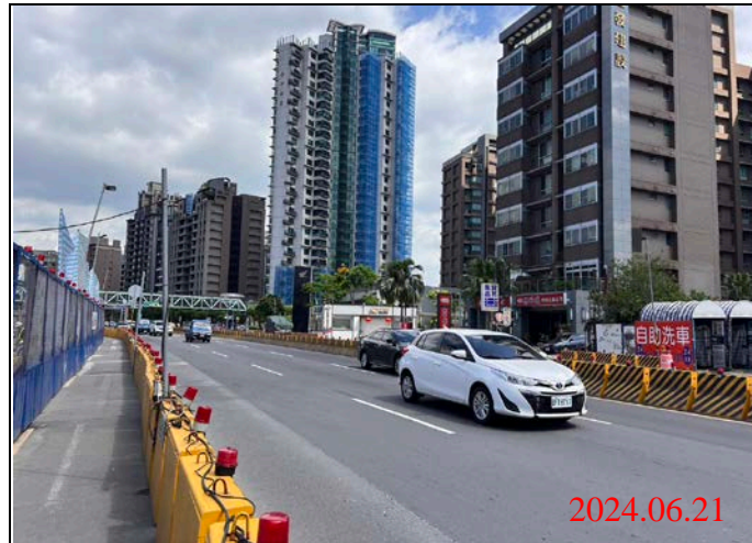
巡查日期地點：113.06.21/23車站 照片說明：路面狀況
