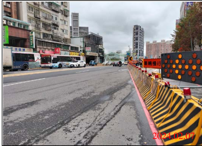
巡查日期地點：113.02.07/ Y22車站 照片說明：路面狀況
