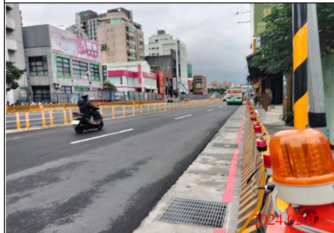
巡查日期地點：113.02.07/ Y21車站 照片說明：路面狀況
