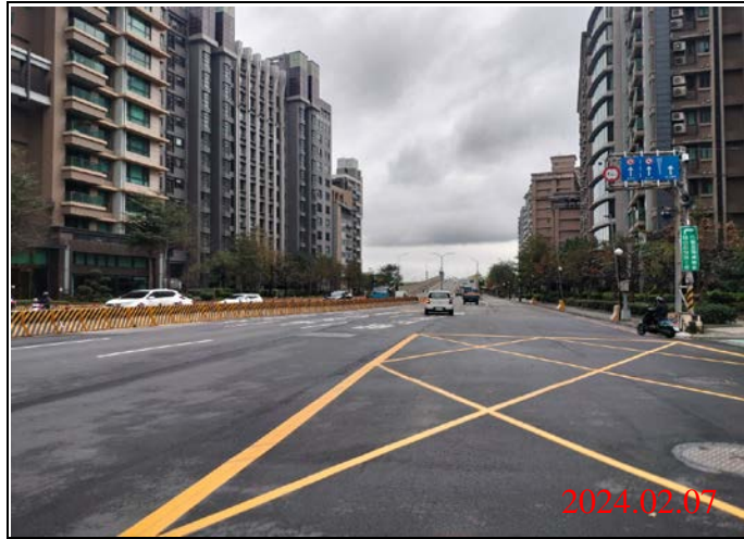
巡查日期地點：113.02.07/ Y23車站 照片說明：路面狀況
