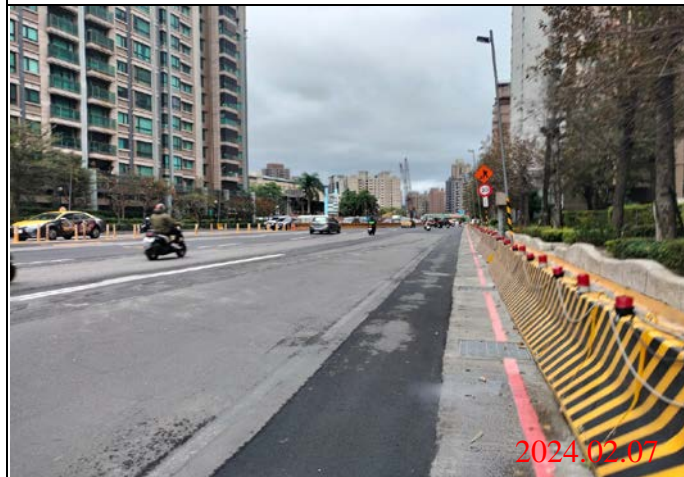
巡查日期地點：113.02.07/ Y23車站 照片說明：路面狀況
