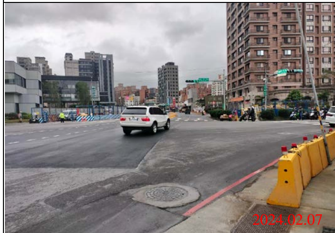
巡查日期地點：113.02.07/ Y22車站 照片說明：路面狀況
