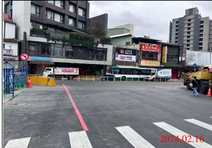
巡查日期地點：113.02.16/ Y21車站 照片說明：路面狀況
