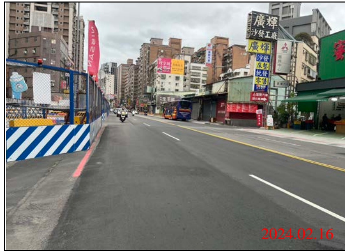
巡查日期地點：113.02.16/ Y22車站 照片說明：路面狀況
