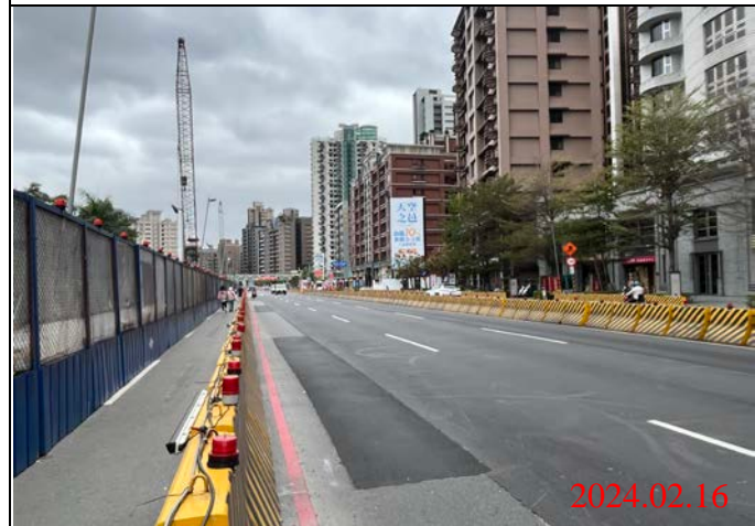
巡查日期地點：113.02.16/ Y23車站 照片說明：路面狀況
