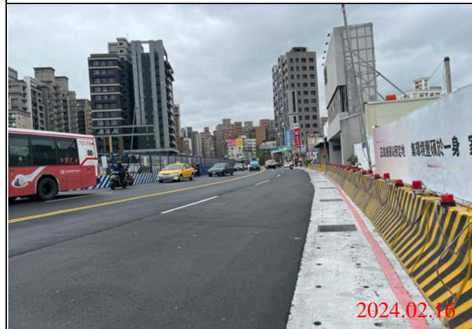
巡查日期地點：113.02.16/ Y22車站 照片說明：路面狀況
