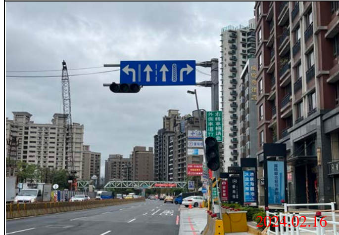
巡查日期地點：113.02.16/ Y23車站 照片說明：牌面設置狀況
