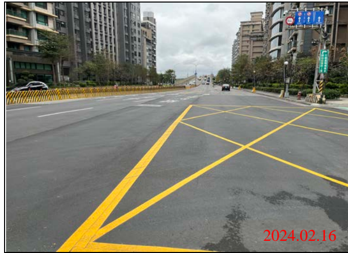
巡查日期地點：113.02.16/ Y23車站 照片說明：路面狀況
