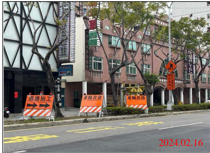
巡查日期地點：113.02.16/ Y21車站 照片說明：牌面設置狀況
