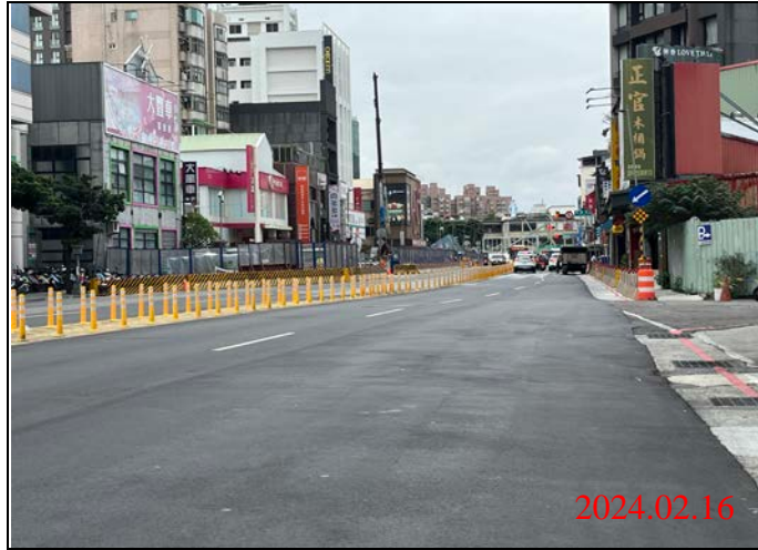
巡查日期地點：113.02.16/ Y21車站 照片說明：路面狀況
