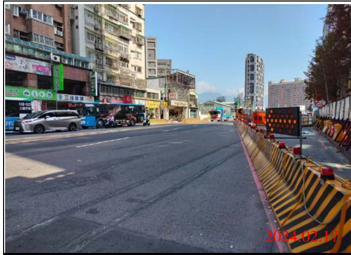
巡查日期地點：113.02.17/ Y22車站 照片說明：路面狀況
