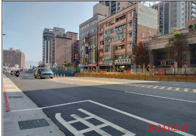
巡查日期地點：113.02.17/ Y22車站 照片說明：路面狀況
