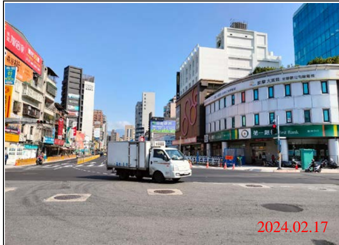
巡查日期地點：113.02.17/ Y21車站 照片說明：路面狀況
