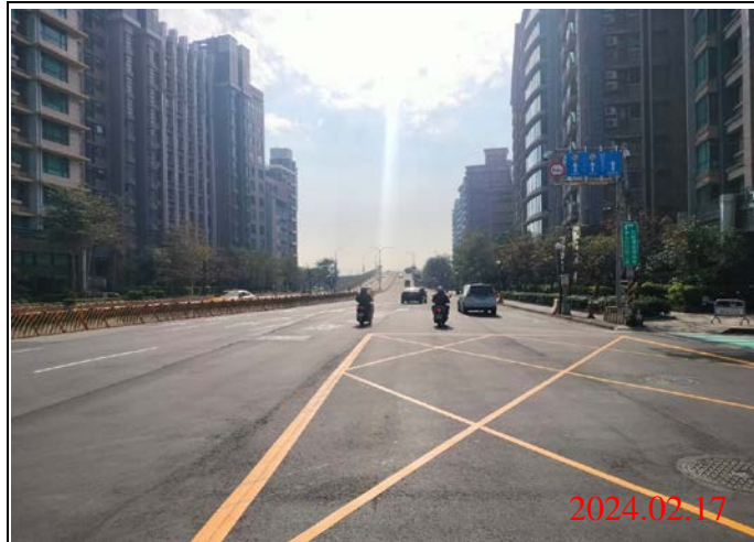
巡查日期地點：113.02.17/ Y23車站 照片說明：路面狀況
