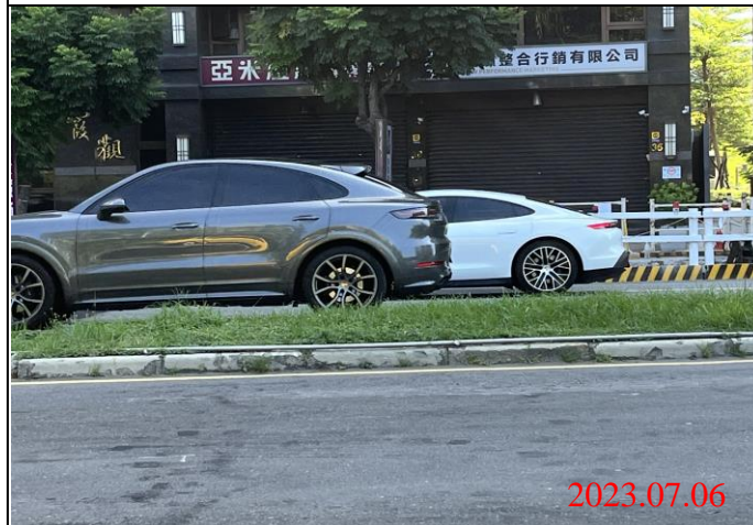
巡查日期地點：112.07.06/ Y23車站 照片說明：路面龜裂狀況
