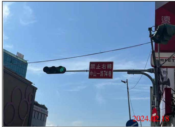
巡查日期地點：113.02.18/ Y21車站 照片說明：牌面設置狀況
