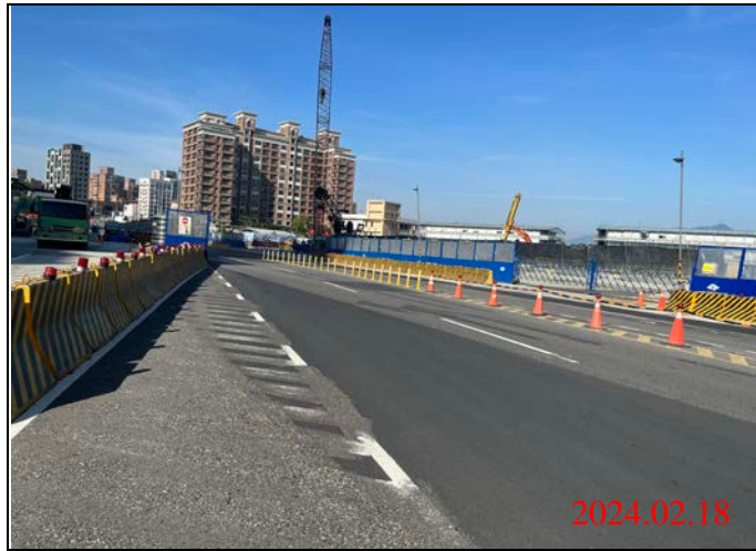
巡查日期地點：113.02.18/ Y22車站 照片說明：路面狀況
