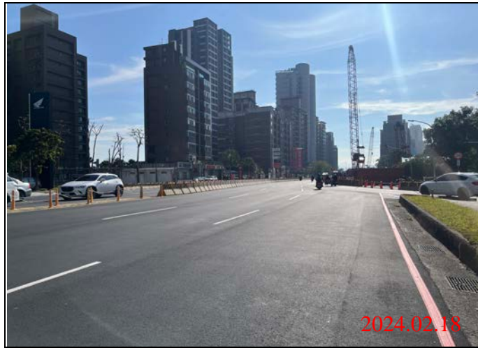
巡查日期地點：113.02.18/ Y23車站 照片說明：路面狀況
