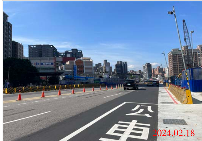
巡查日期地點：113.02.18/ Y22車站 照片說明：路面狀況
