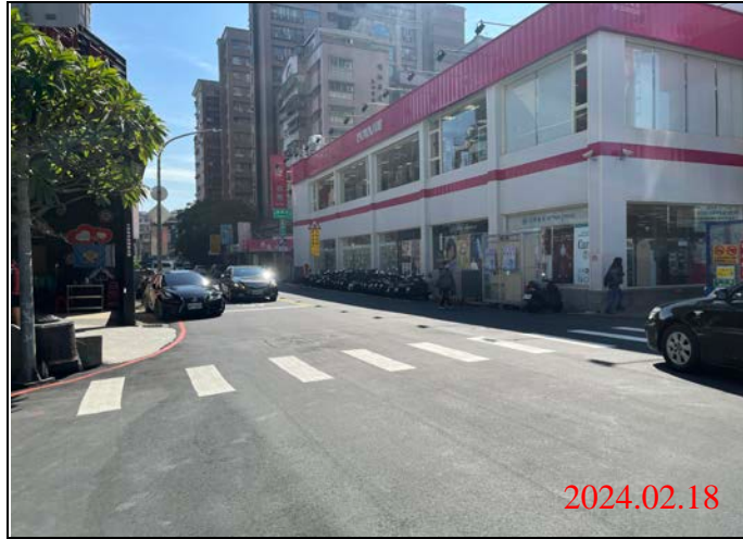
巡查日期地點：113.02.18/ Y21車站 照片說明：路面狀況
