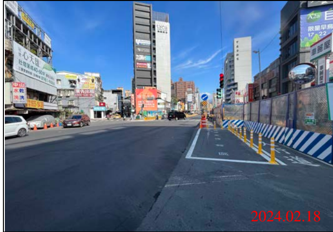
巡查日期地點：113.02.18/ Y21車站 照片說明：路面狀況
