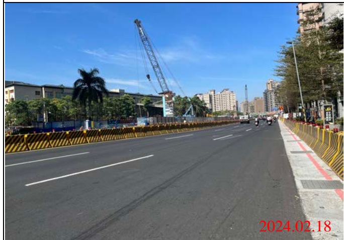
巡查日期地點：113.02.18/ Y23車站 照片說明：路面狀況
