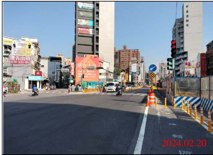
巡查日期地點：113.02.20/ Y21車站 照片說明：路面狀況
