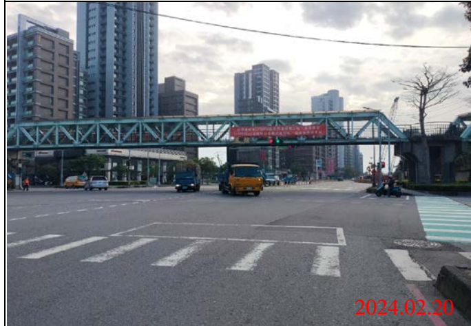
巡查日期地點：113.02.20/ Y23車站 照片說明：路面狀況
