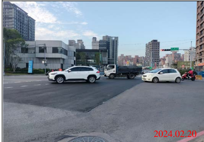
巡查日期地點：113.02.20/ Y22車站 照片說明：路面狀況
