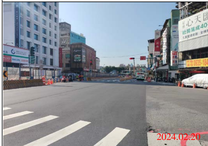
巡查日期地點：113.02.20/ Y21車站 照片說明：路面狀況
