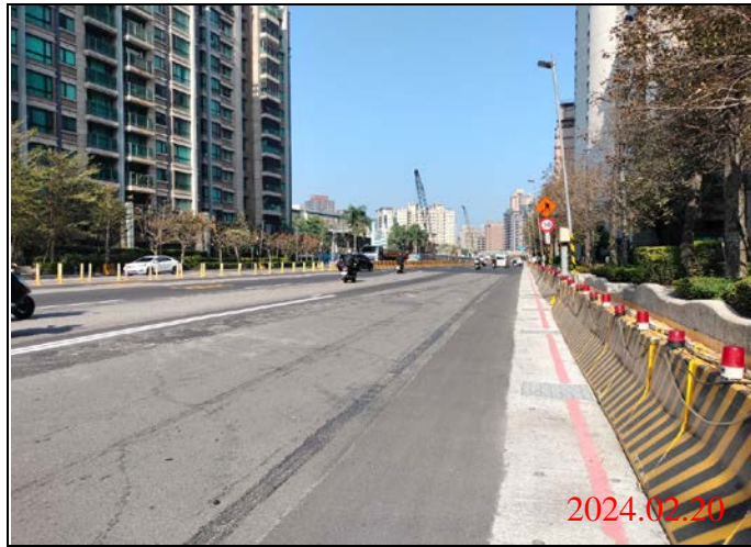
巡查日期地點：113.02.20/ Y23車站 照片說明：路面狀況
