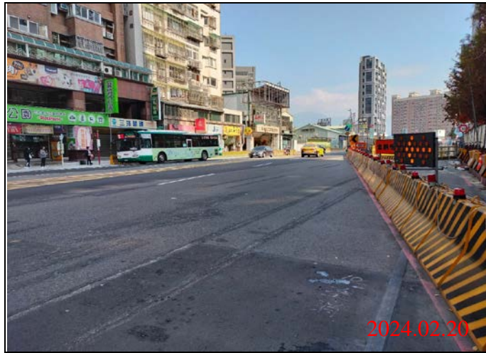
巡查日期地點：113.02.20/ Y22車站 照片說明：路面狀況
