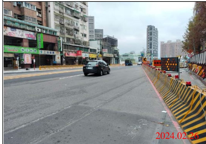
巡查日期地點：113.02.26/ Y22車站 照片說明：路面狀況
