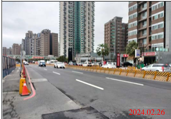
巡查日期地點：113.02.26/ Y23車站 照片說明：路面狀況
