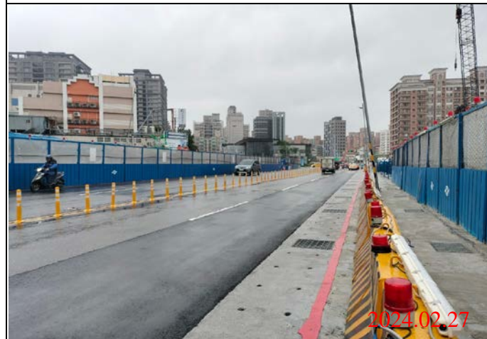
巡查日期地點：113.02.27/ Y22車站 照片說明：路面狀況
