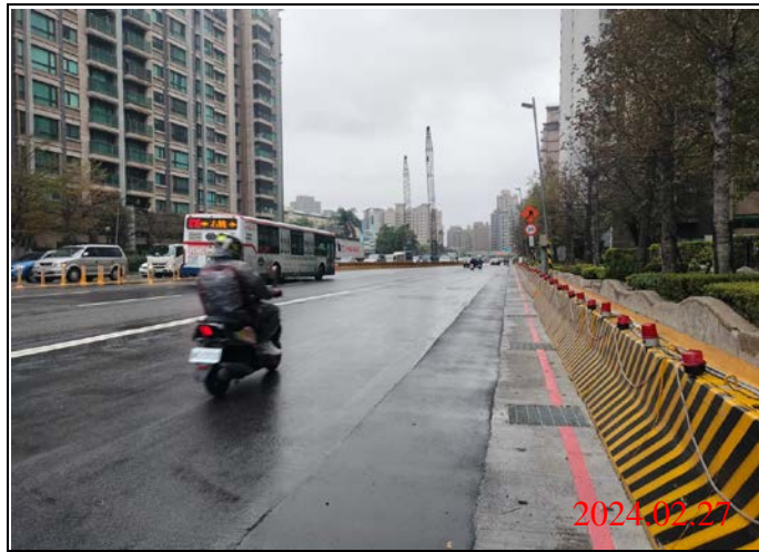
巡查日期地點：113.02.27/ Y23車站 照片說明：路面狀況
