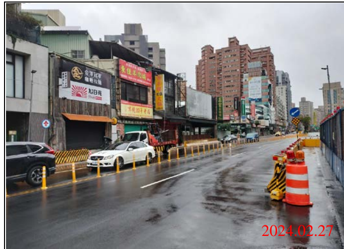
巡查日期地點：113.02.27/ Y21車站 照片說明：路面狀況
