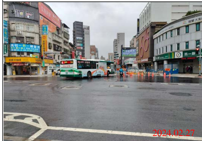
巡查日期地點：113.02.27/ Y21車站 照片說明：路面狀況
