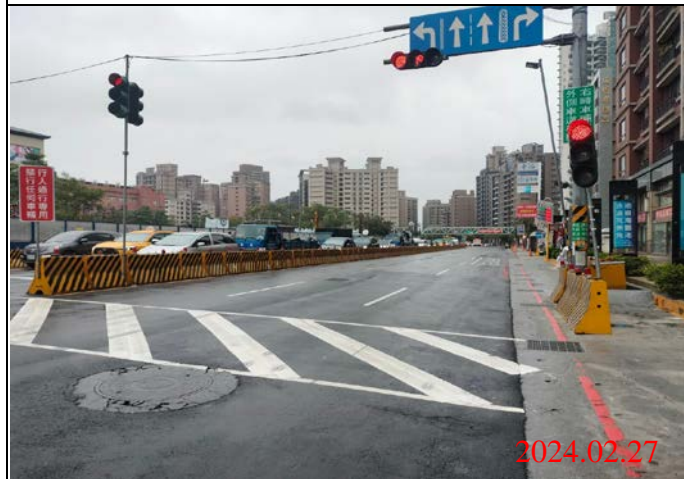
巡查日期地點：113.02.27/ Y23車站 照片說明：路面狀況
