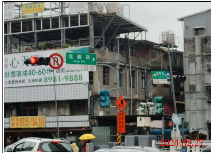
巡查日期地點：113.02.27/ Y21車站 照片說明：牌面設置狀況
