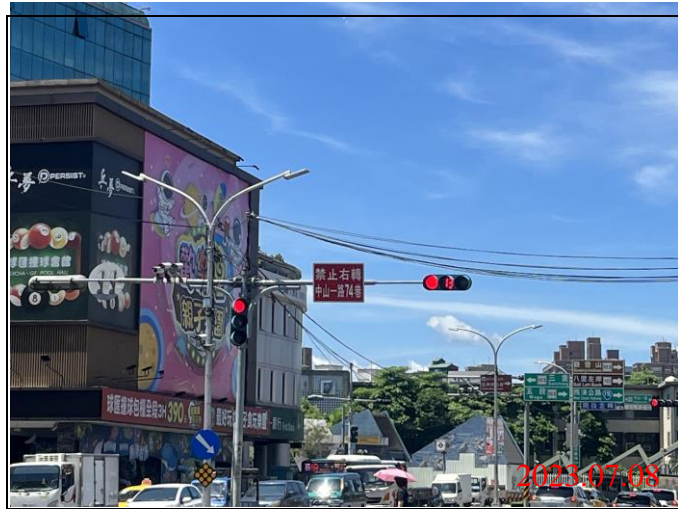
巡查日期地點：112.07.08/ Y21車站 照片說明：牌面設置狀況
