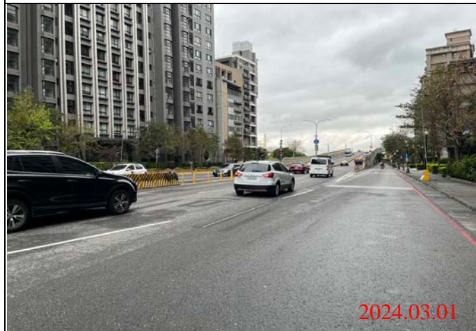
巡查日期地點：113.03.01/ Y23車站 照片說明：路面狀況
