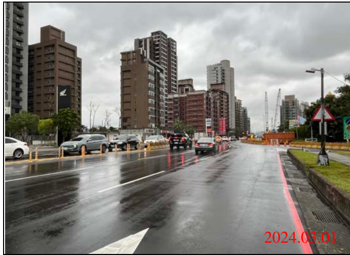
巡查日期地點：113.03.01/ Y23車站 照片說明：路面狀況
