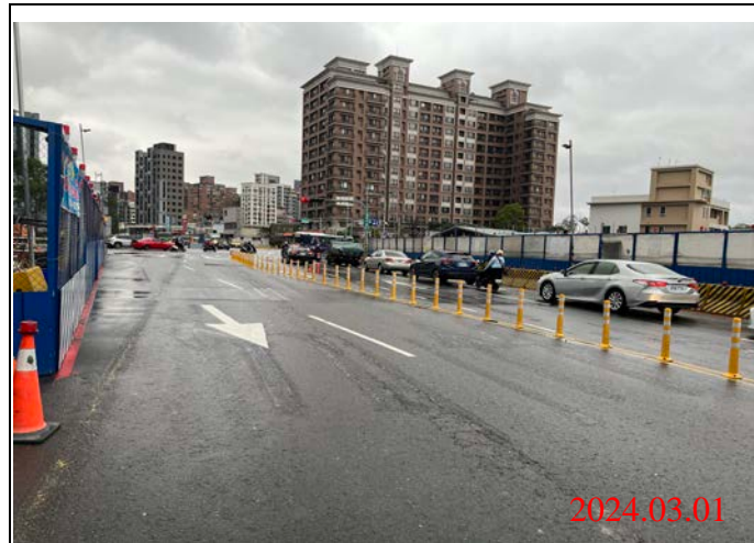
巡查日期地點：113.03.01/ Y22車站 照片說明：路面狀況
