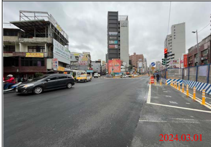
巡查日期地點：113.03.01/ Y21車站 照片說明：路面狀況
