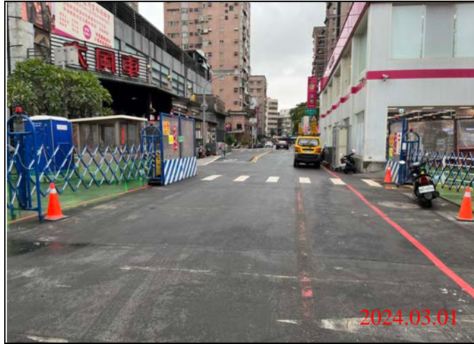
巡查日期地點：113.03.01/ Y21車站 照片說明：路面狀況
